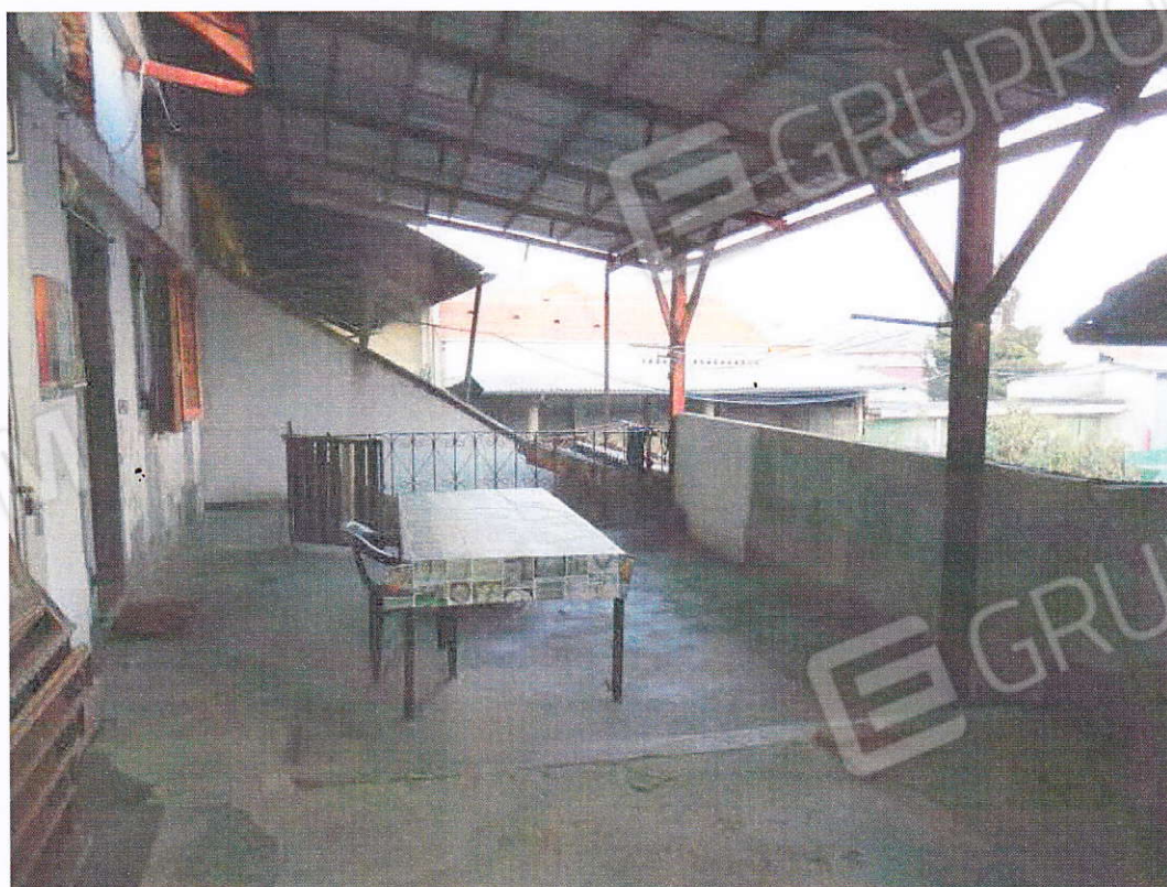
Piano primo – terrazzo coperto antistante l'ingresso dell'appartamento
