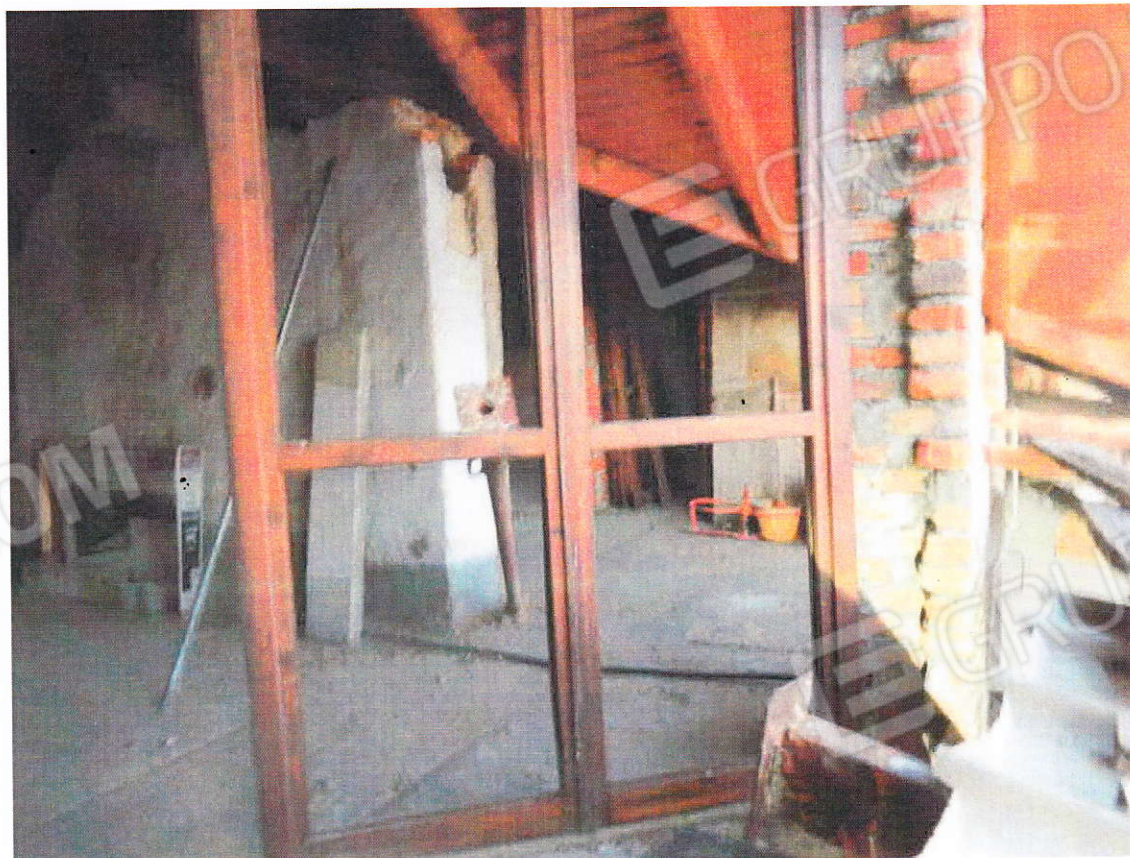
Piano secondo – vista da scala di accesso
