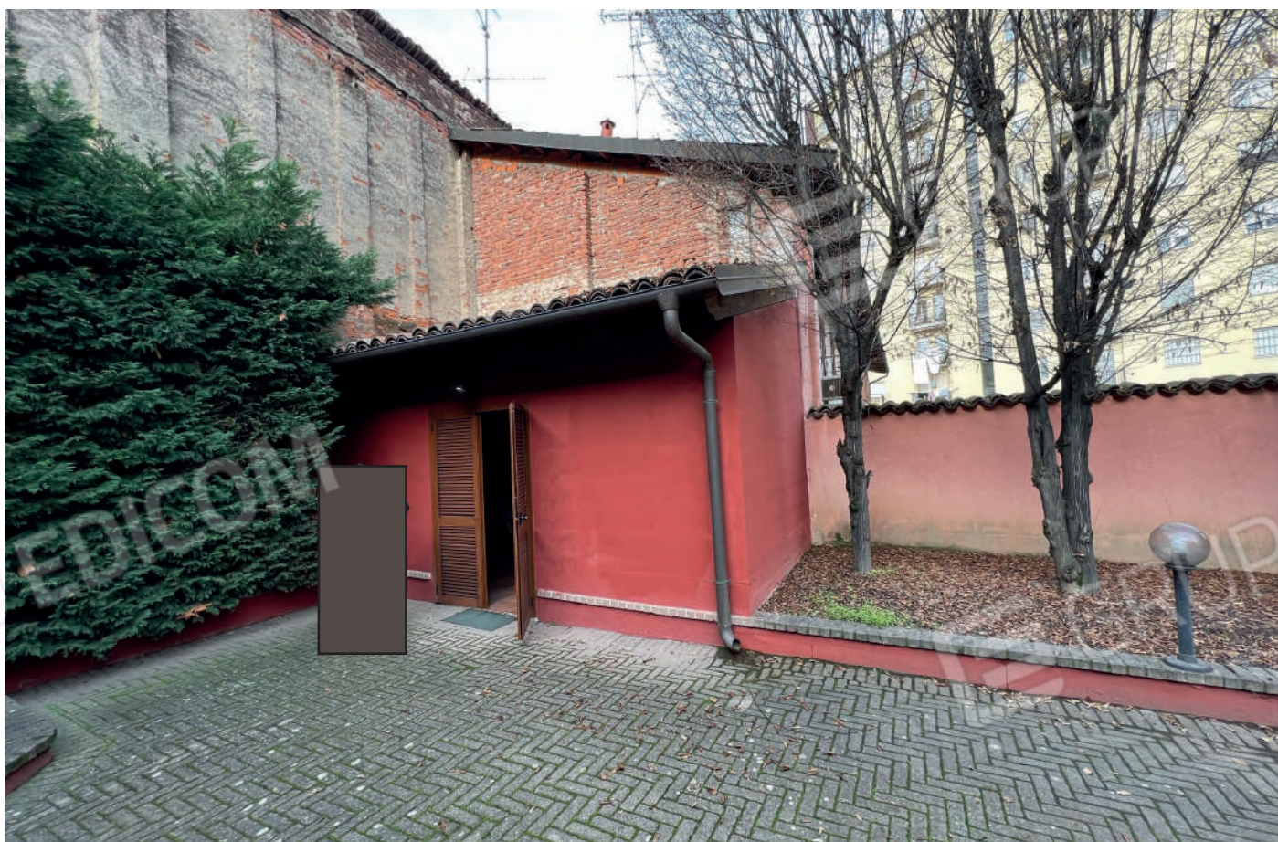
17_Fabbricato pertinenziale esterno
