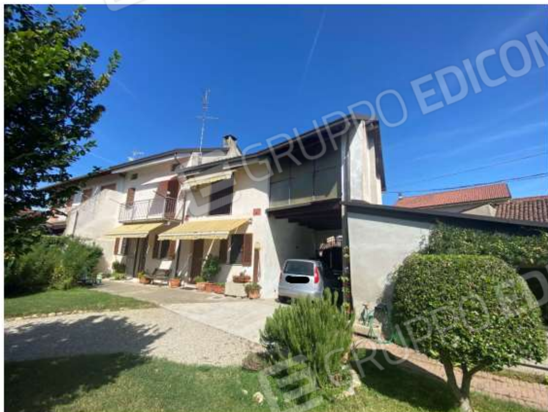
FOTO 21 : VISTA ESTERNA DELL'ABITAZIONE LATO CORTILE
