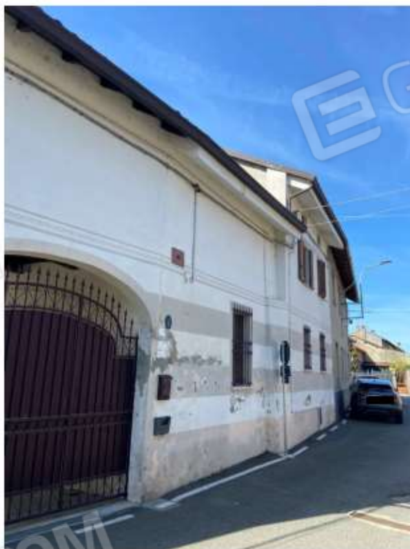
FOTO 2 : VISTA ESTERNA LATO VIA NAVAZZOTTI
