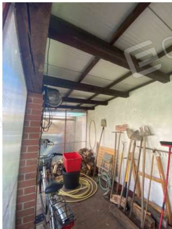
FOTO 18 : VISTA INTERNA PORTICATO PIANO TERRENO
