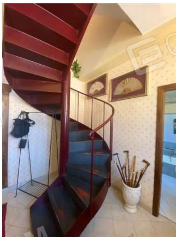
FOTO 8 : VISTA INTERNA VANO SCALA PIANO TERRENO
