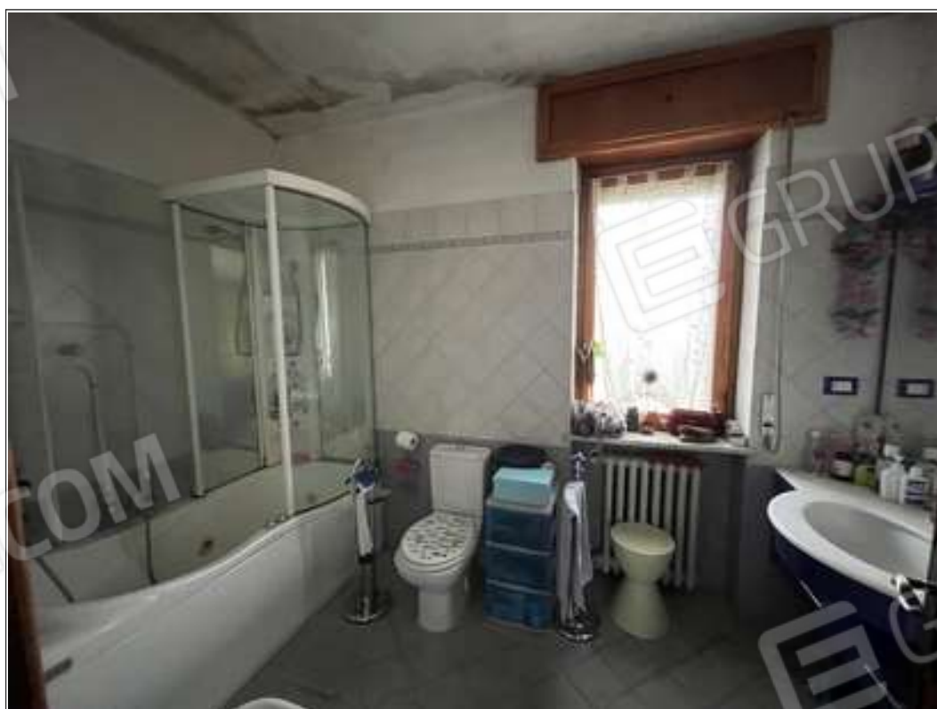
FOTO 6: vista del bagno verso la parete Nord
