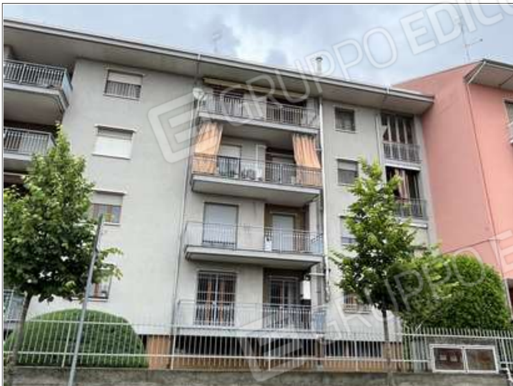
FOTO 15: vista della facciata Sud del Condominio Livio su via Cristoforo Colombo
