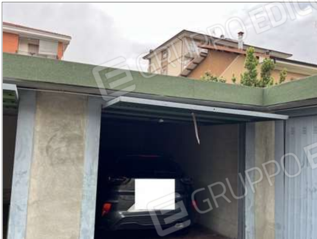
FOTO 13: vista del box-auto nel cortile interno
