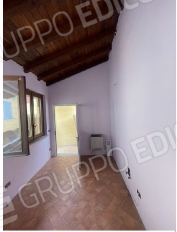
Figura 12. Ripostiglio al Piano Primo.
