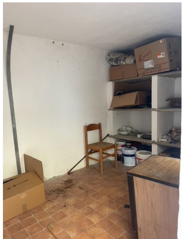
Figura 6. Ripostiglio al Piano Terra.
