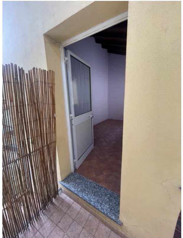
Figura 14. Ripostiglio al Piano Primo / Balcone.
