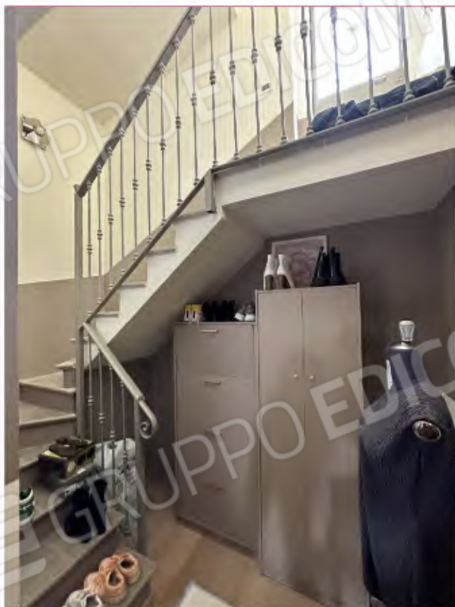
SCALA D'ACCESSO AL TERRAZZO - SUB 52 - ZONA NOTTE-P3
