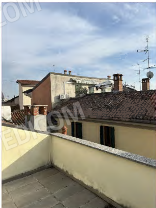
TERRAZZO - SUB 52 - ACCESSO DA ZONA NOTTE-P4
