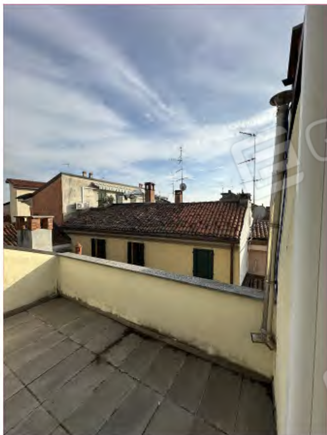
TERRAZZO - SUB 52 - ACCESSO DA ZONA NOTTE - P4
