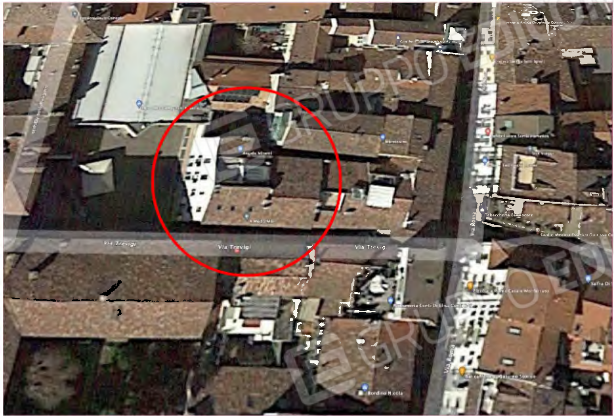
L'IMMOBILE OGGETTO DI PERIZIA
