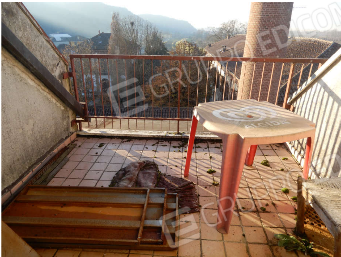
Piano 3° sottotetto – terrazzino a servizio della camera
