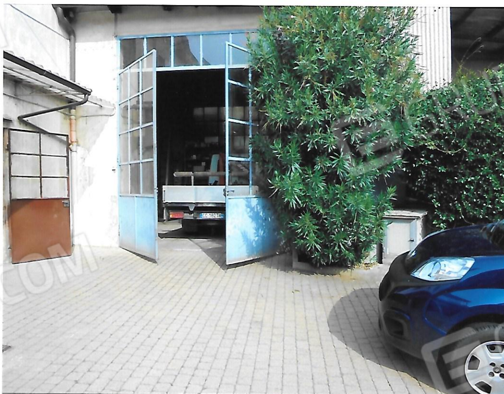
Foto 4 – Secondo prospetto da cortile su Via S.Lorenzo
