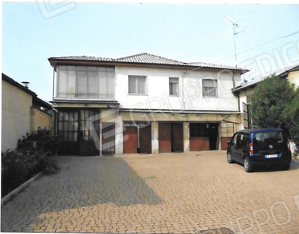
Foto 3 –Prospetto cortile da Via S.Lorenzo-solo Piano terra
