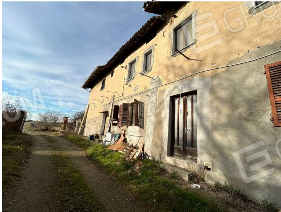
Foto 2 – vista da cortile
