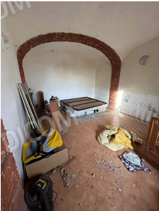
Foto 9 – camera piano terra
