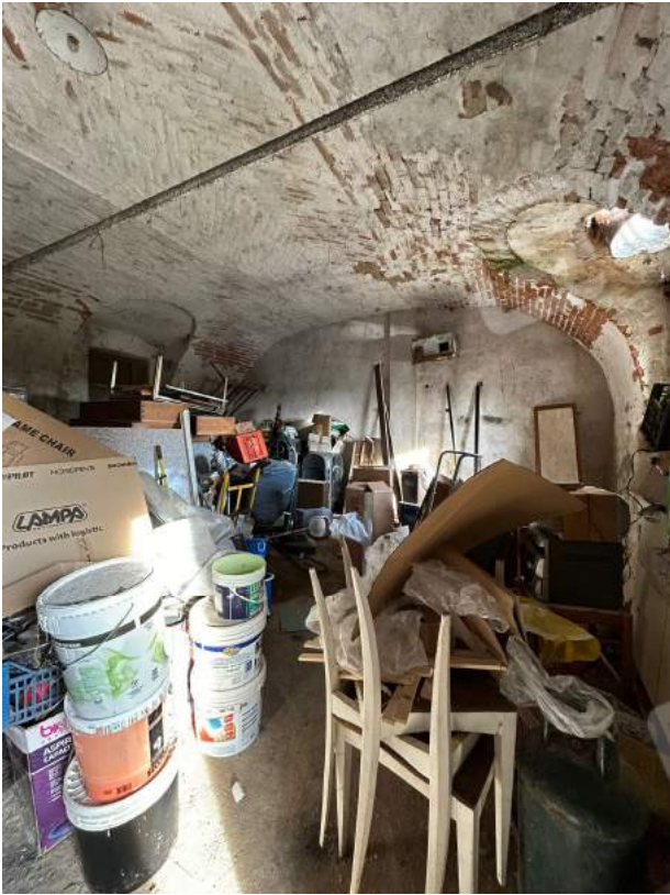
Foto 7 – magazzino piano terra
