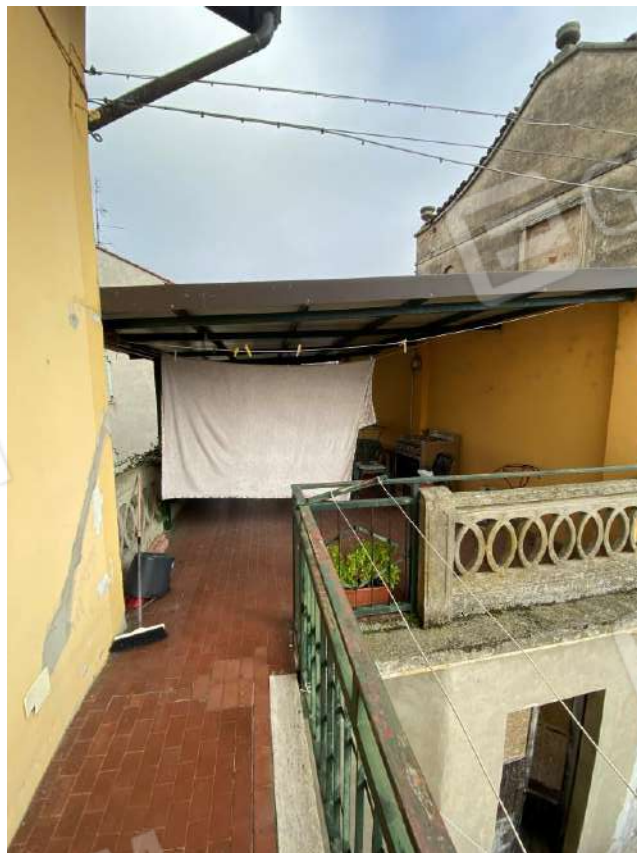
FOTO 25 : VISTA D'INSIEME ESTERNA PIANO PRIMO – TERRAZZA
