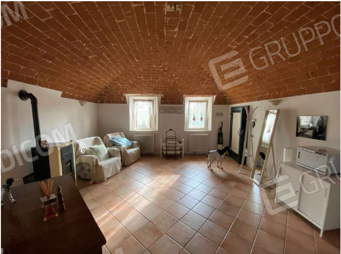
FOTO 17 : VISTA D'INSIEME INTERNA PIANO TERRENO – TAVERNETTA
