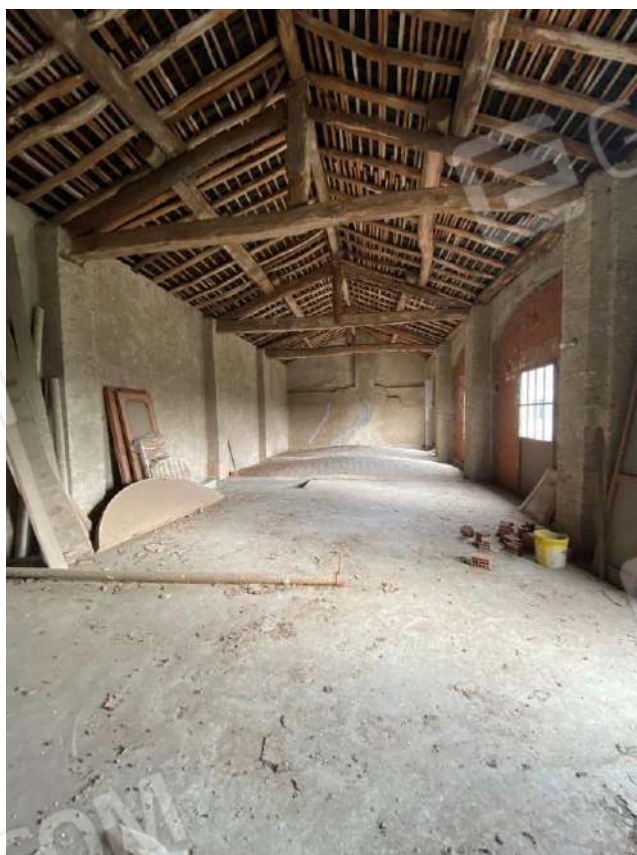
FOTO 9 : VISTA D'INSIEME INTERNA PIANO PRIMO - RIPOSTIGLIO
