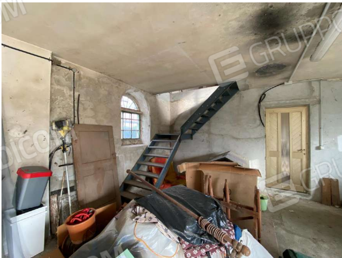
FOTO 6 : VISTA D'INSIEME INTERNA MAGAZZINO-DEPOSITO E TETTOIA
