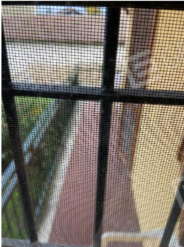
FOTO 27 : VISTA D'INSIEME ESTERNA PIANO PRIMO BALCONE
