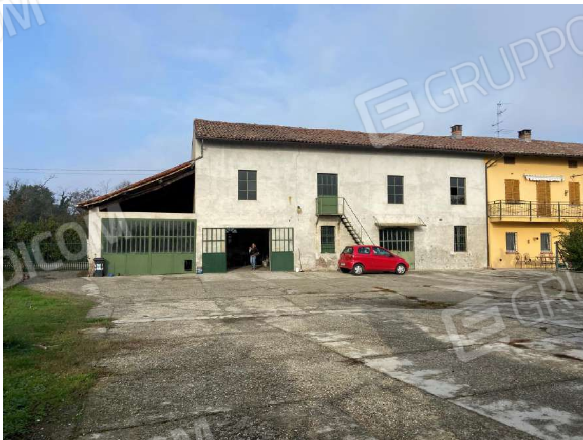
FOTO 4 : VISTA D'INSIEME ESTETRNA MAGAZZINO-DEPOSITO E TETTOIA
