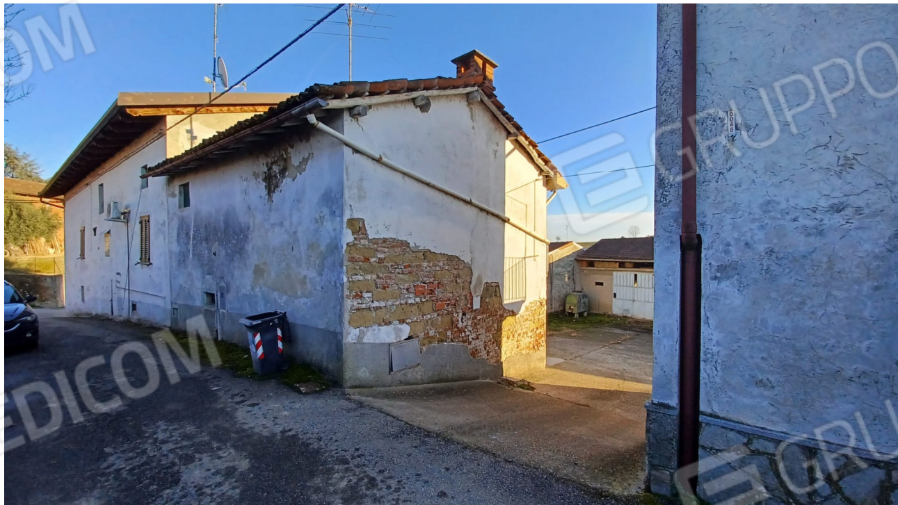
Foto 2 – vista da strada
