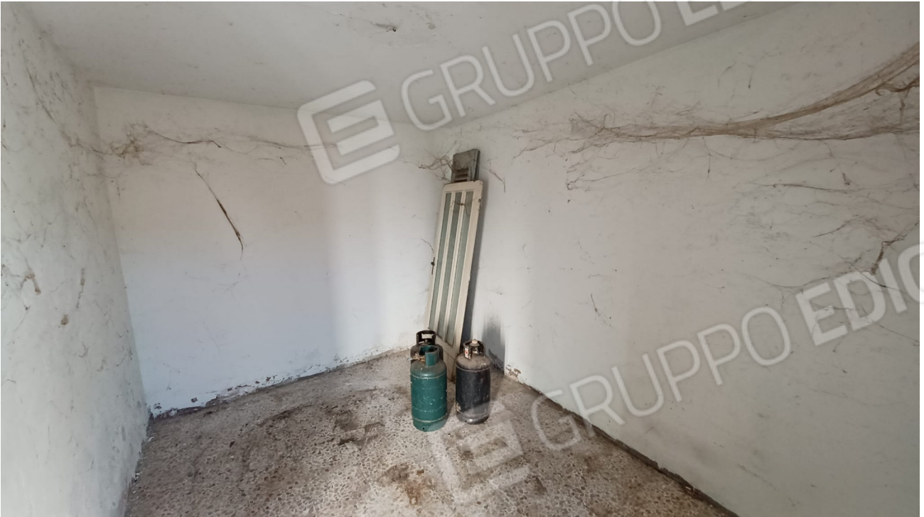
Foto 5 – camera piano terra
