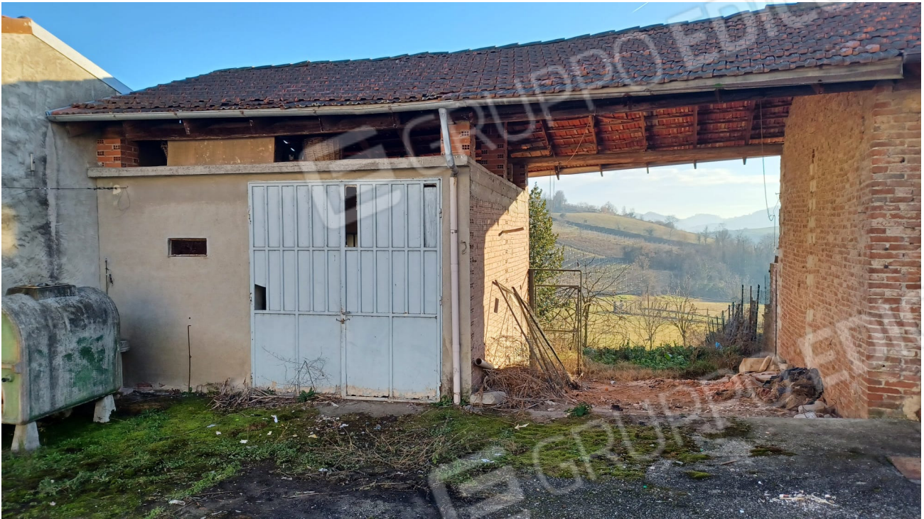
Foto 3 – vista da cortile – fabbricato accessorio -
