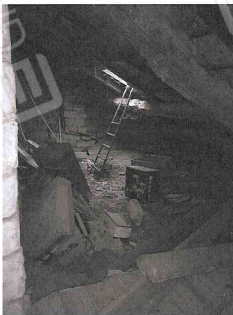
Piano Secondo – Locale Sottotetto 1 con lastre di copertura di cui al Quesito 1
