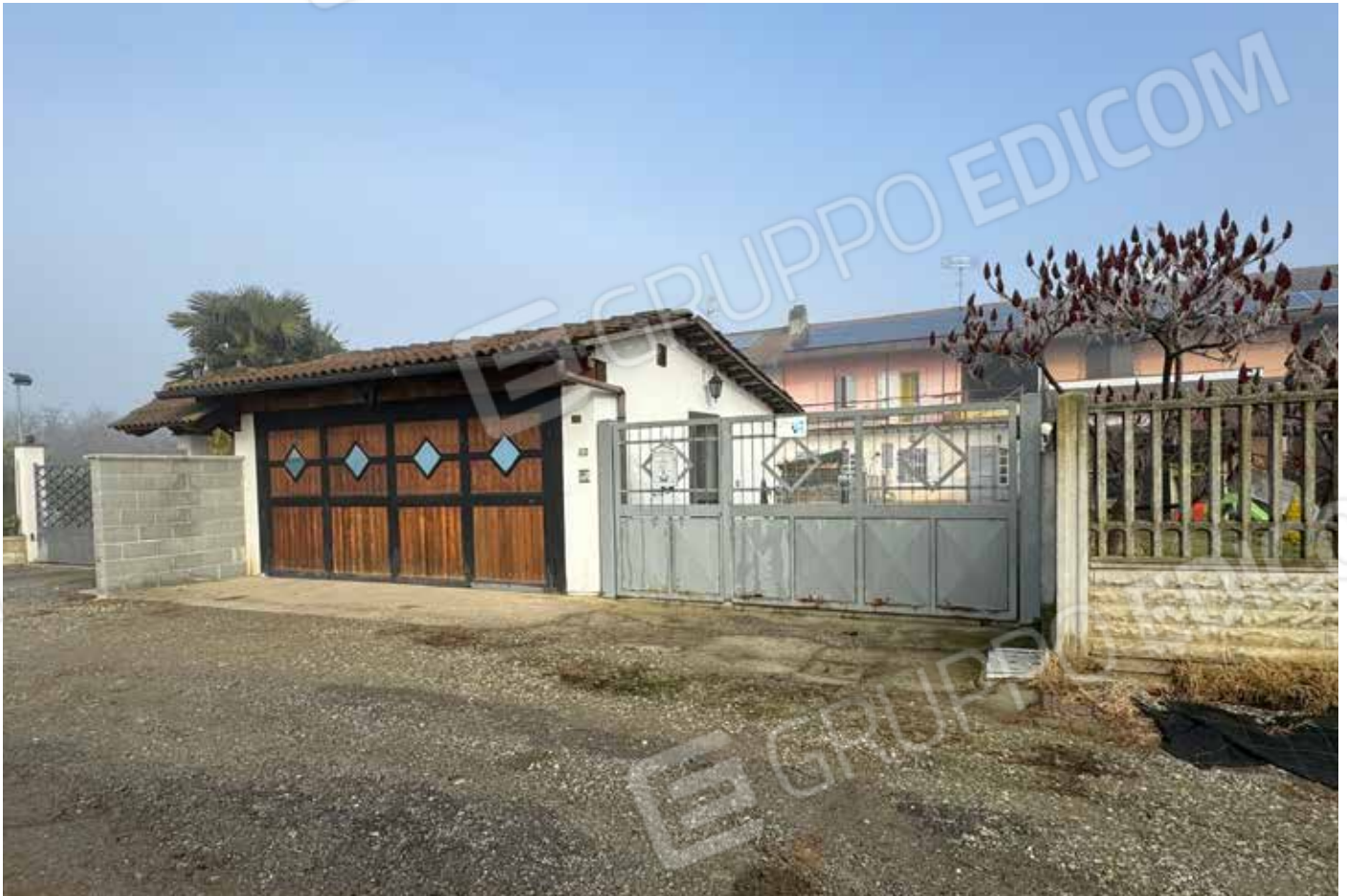
L'ingresso Pedonale e Carraio e del Box Auto da Via Giuseppe Nicoletto n. 30 - Saluggia - (foto del 19.01.24)
