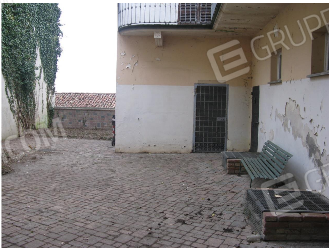
Foto 8 – Facciata sud-est interno cortile
