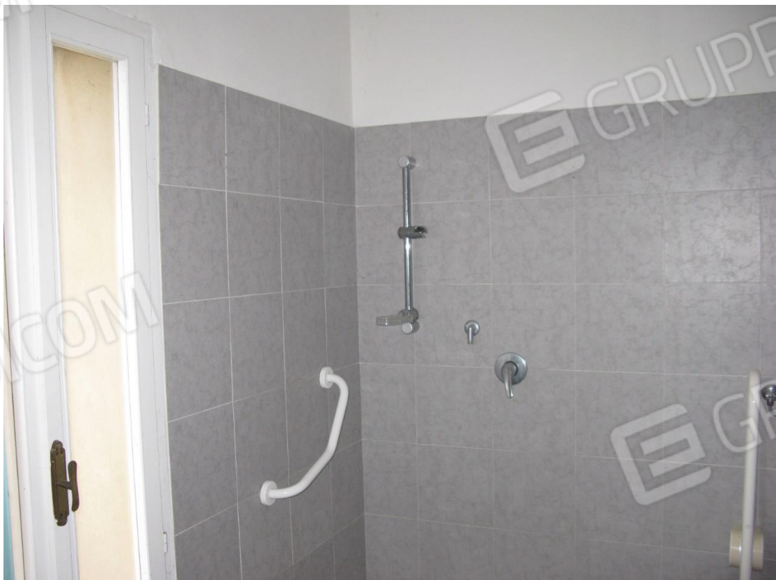
Foto 18 – Bagno disabili al piano terreno
