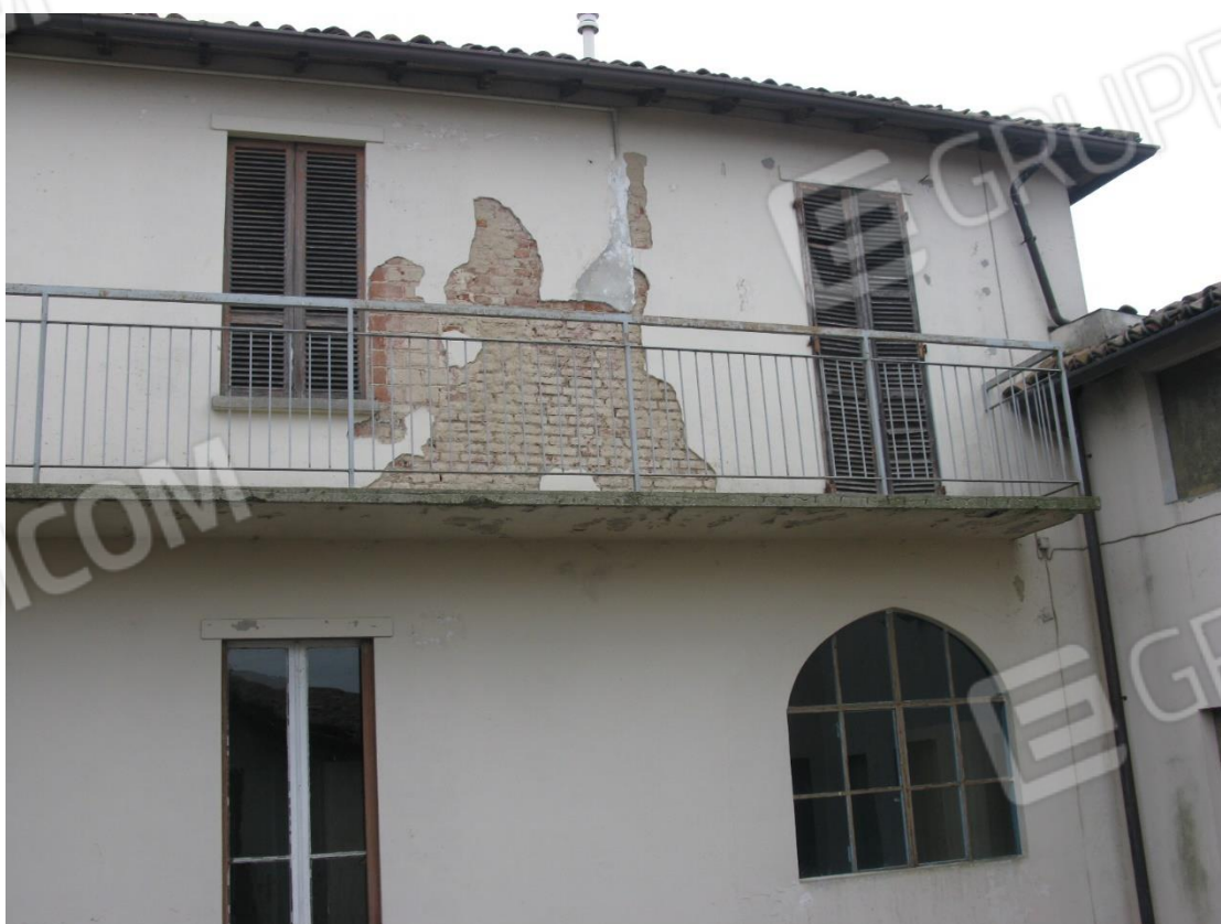
Foto 6 – Facciata ovest interno cortile
