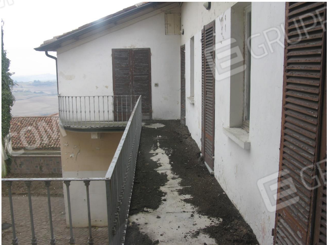
Foto 32 – Balcone piano primo
