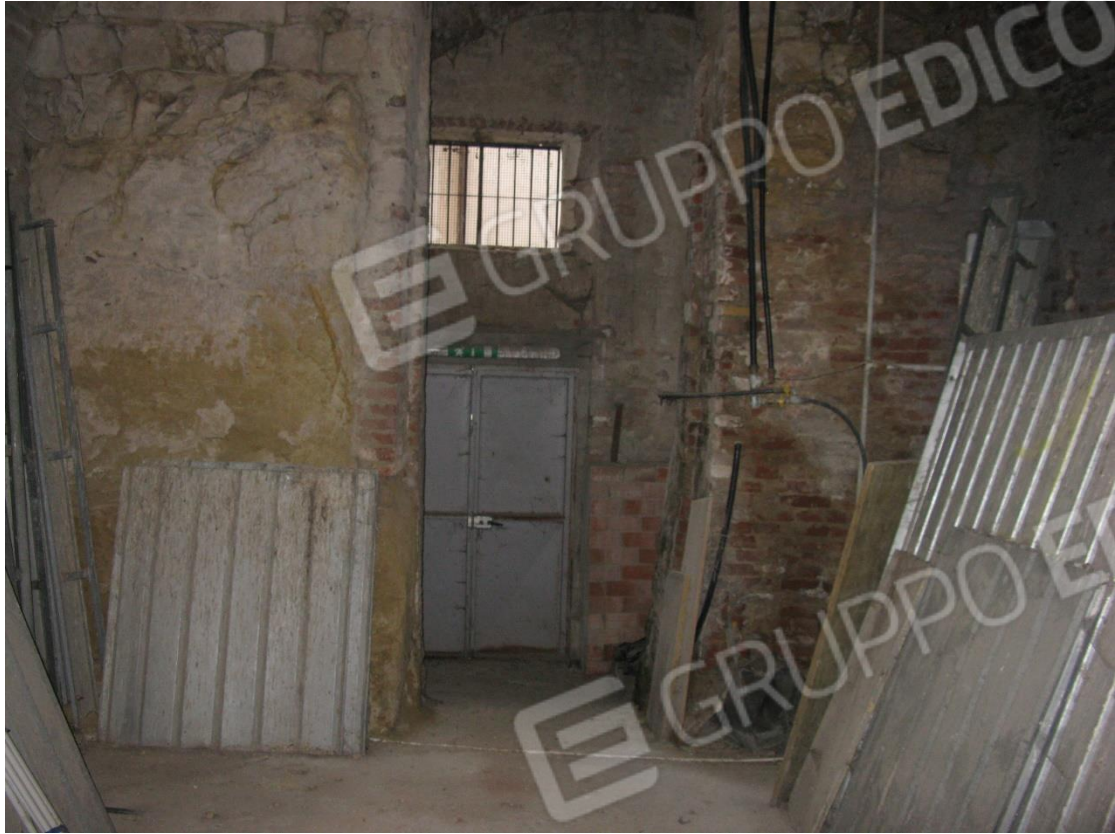
Foto 41 – Porta di accesso su via Garibaldi locale aula riunione
