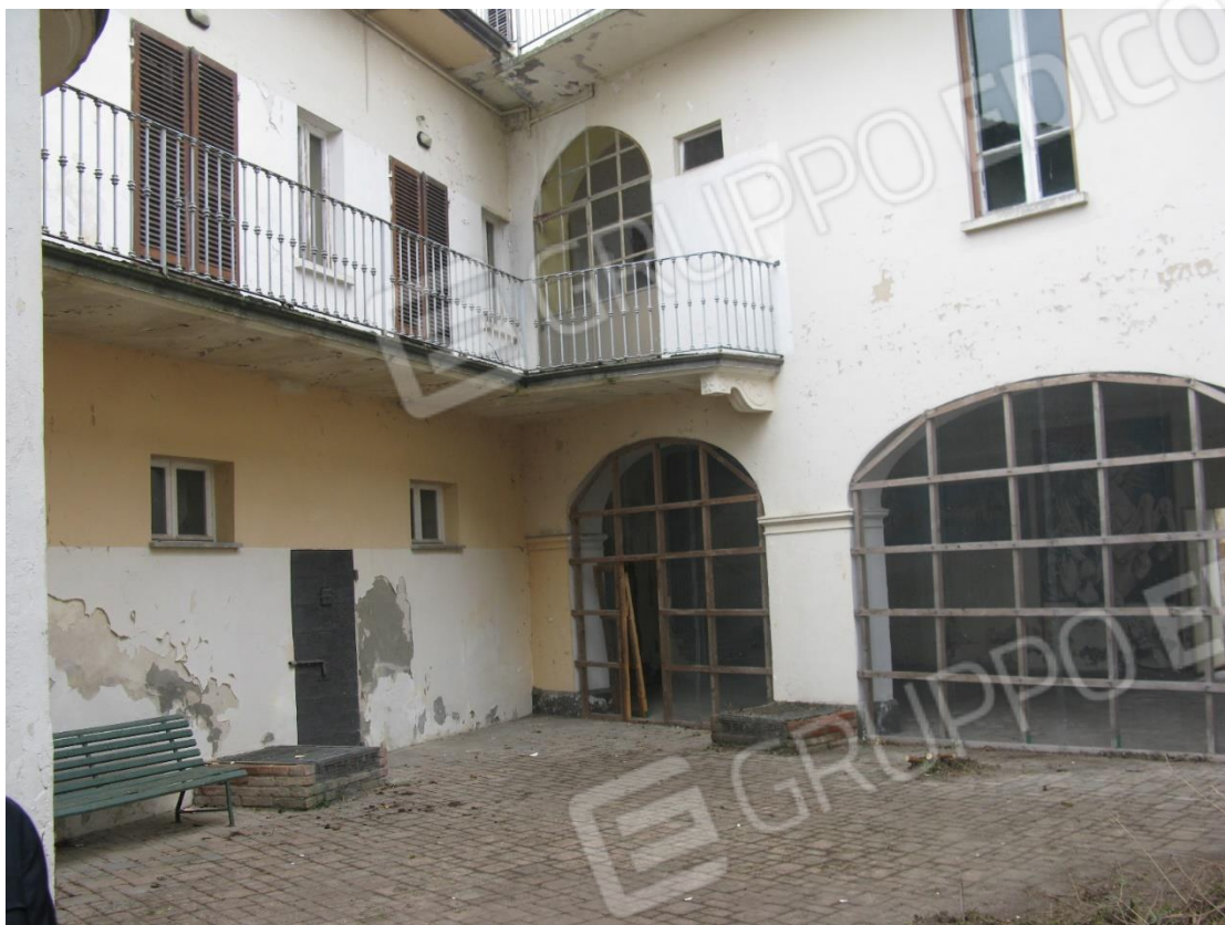
Foto 3 – Facciata ovest interno cortile
