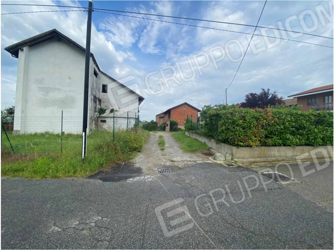
FOTO 1 Accesso dalla strada pubblica
