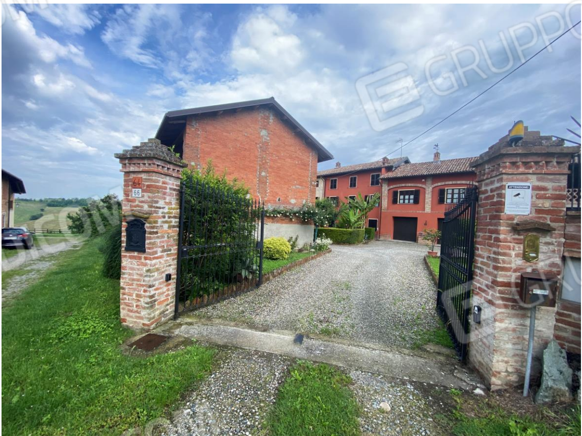
FOTO 2 Accesso tramite il cortile privato del mappale 192
