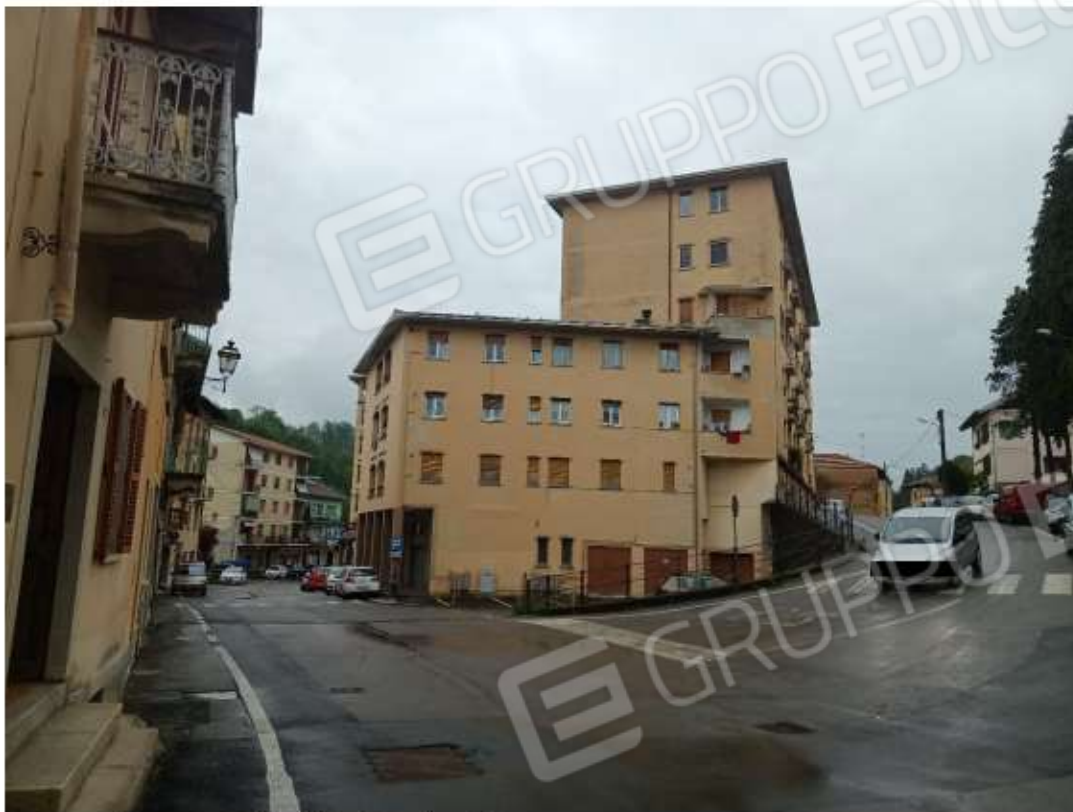
Prospetto Nord-Est Condominio CENTRO RESIDENZIALE VALDUGGIA
