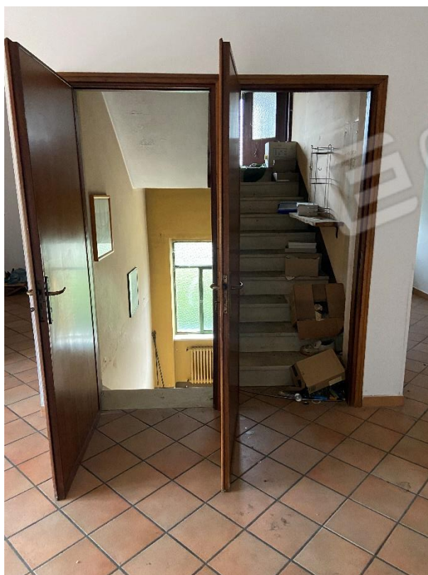
FOTO 6: VISTA INTERNA INGRESSO SECONDARIO (VANO SCALA) PASSANTE DALL'APPARTAMENTO PIGNORATO AL SOTTOTETTO COMUNE
