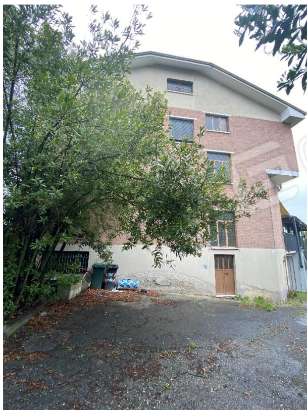
FOTO 4: VISTA ESTERNA INGRESSO SECONDARIO (PORTA IN FERRO AL VANO SCALA) LATO EDIFICIO VERSO CORTILE INTERNO
