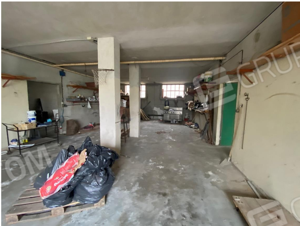
FOTO 20: VISTA INTERNA GARAGE
