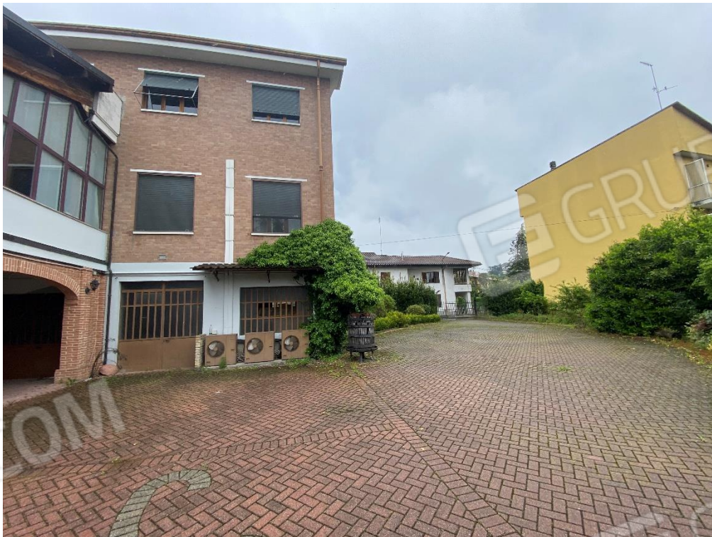
FOTO 18: VISTA ESTERNA INGRESSO GARAGE
