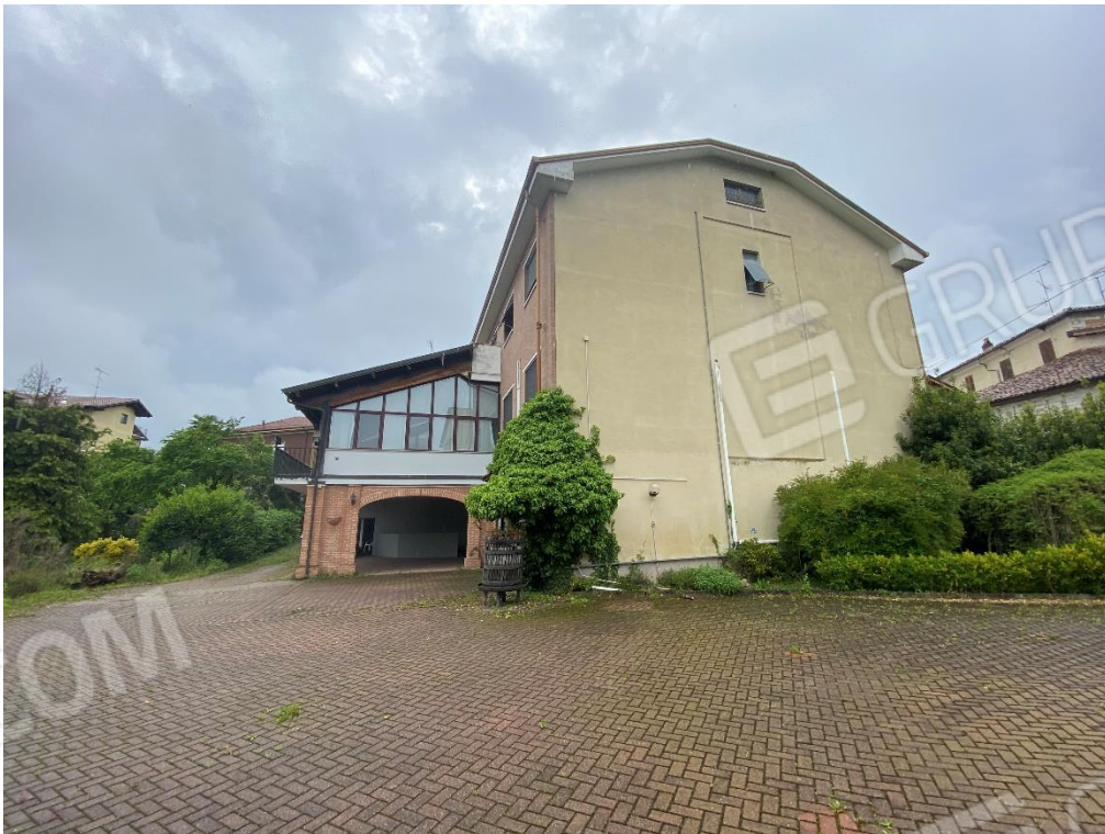
FOTO 8: VISTA LATO EDIFICIO VERSO CORTILE INTERNO
