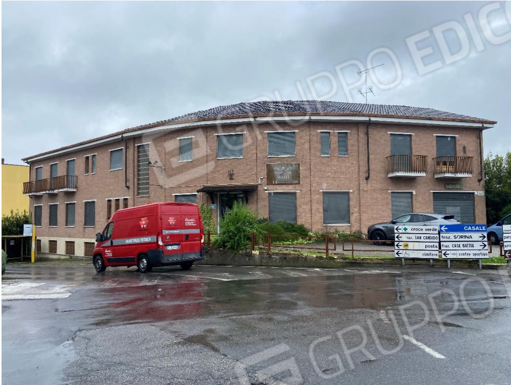
FOTO 1: VISTA FRONTALE INTERO EDIFICIO
