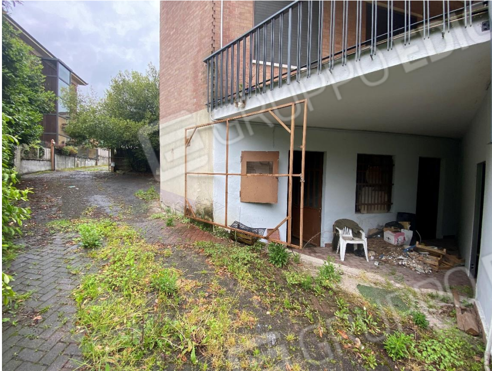
FOTO 21: VISTA ESTERNA INGRESSO LOCALI DI SGOMBERO PIANO SEMINTERRATO
