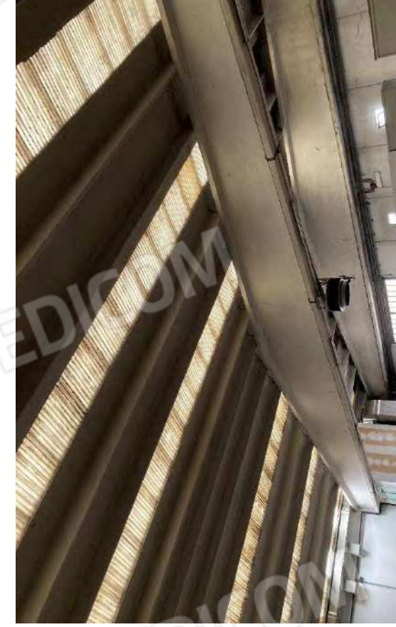
PARTICOLARE COPERTURA DALL'INTERNO OVE SONO VISIBILI LE TRAVI E LE LASTRE ONDULATE IN PLEXIGLASS CHE PERMETTONO L'INGRESSO DELLE LUCE NATURALE; IN CORRISPONDENZA DELLE TRAVI SONO POSATE LASTRE IN FIBROCEMENTO AMIANTO.
