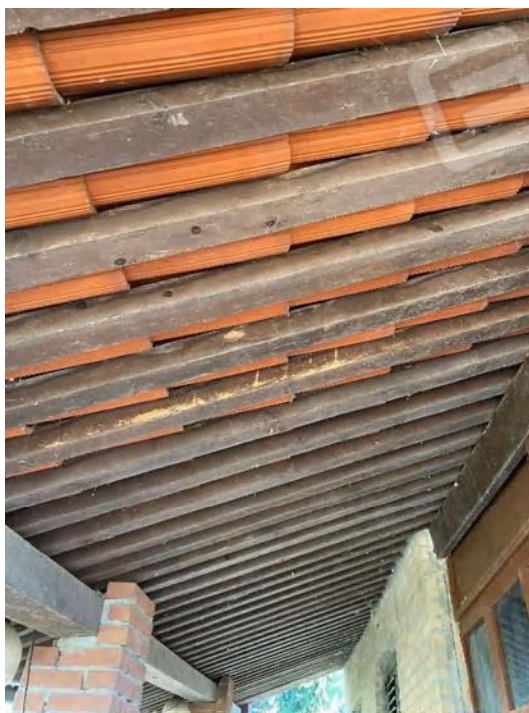
PORTICATO manto di copertura
