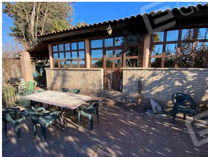
TERRAZZO LATO SUD autorizzato con concessione ma non sulla scheda catastale
