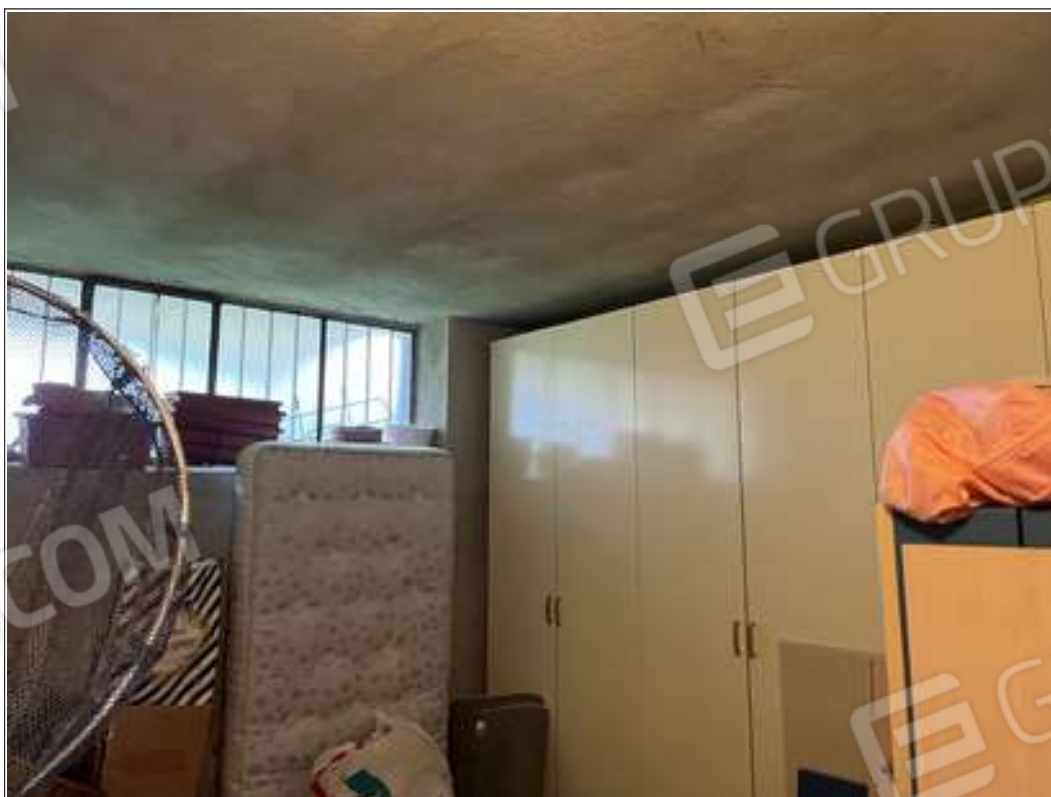
FOTO 12: vista dell'interno della cantina al piano seminterrato
