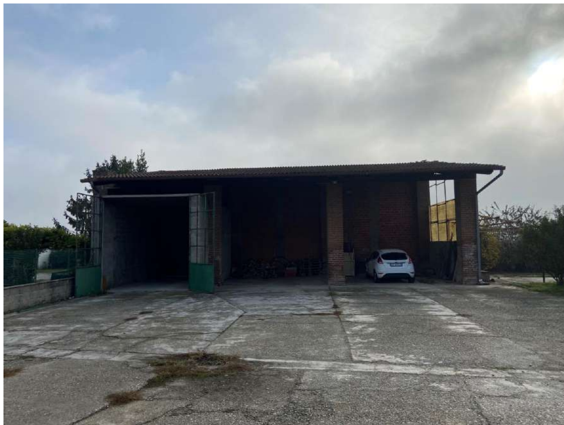
FOTO 1 : VISTA D'INSIEME ESTERNA MAGAZZINO E PORTICI
