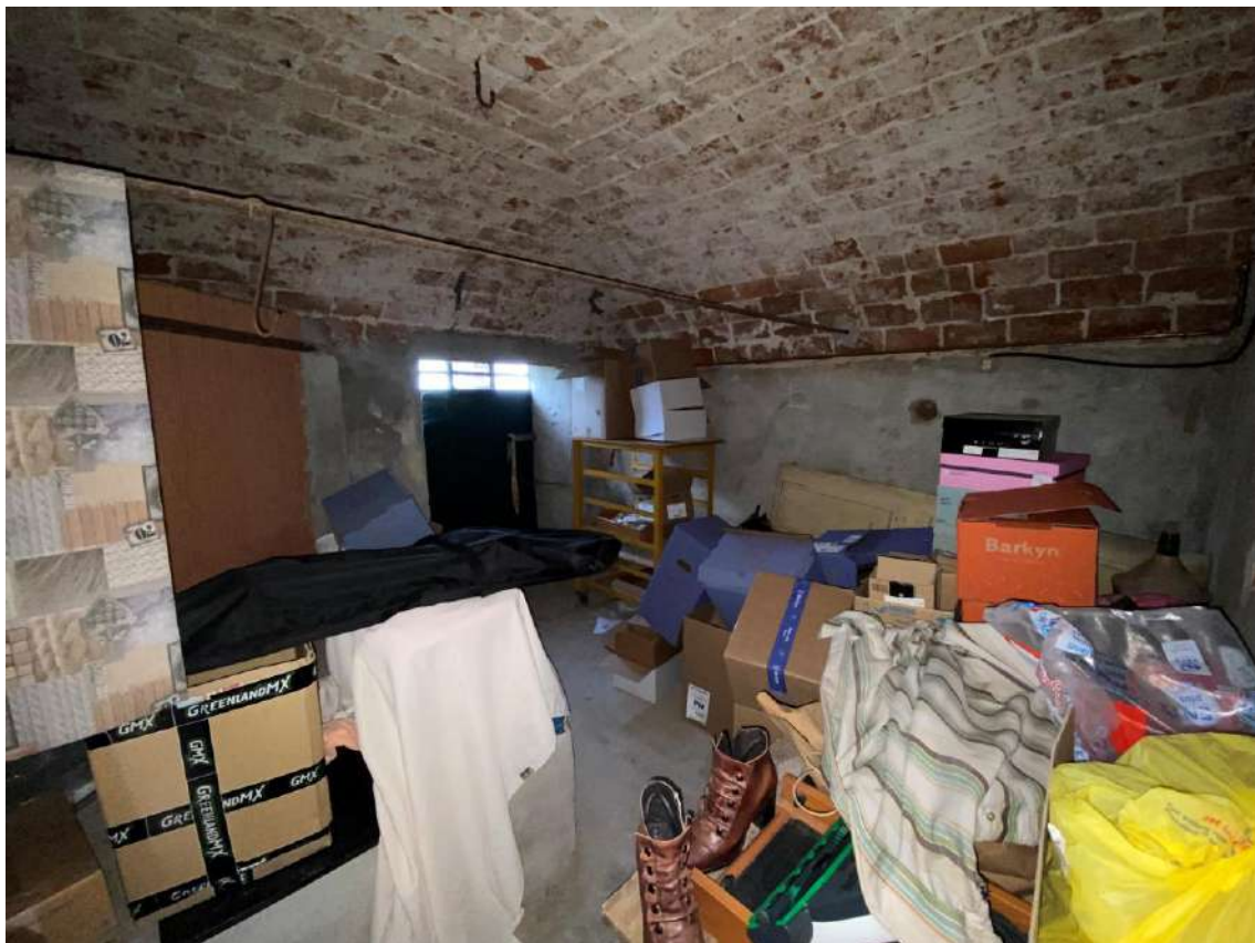
FOTO 12 : VISTA D'INSIEME INTERNA PIANO TERRENO - CANTINA
