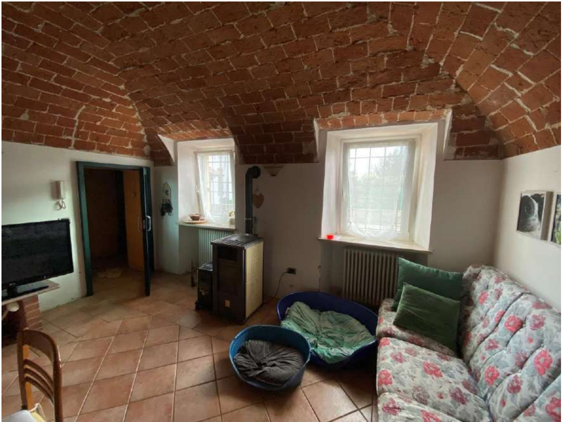
FOTO 14 : VISTA D'INSIEME INTERNA PIANO TERRENO - TAVERNETTA
