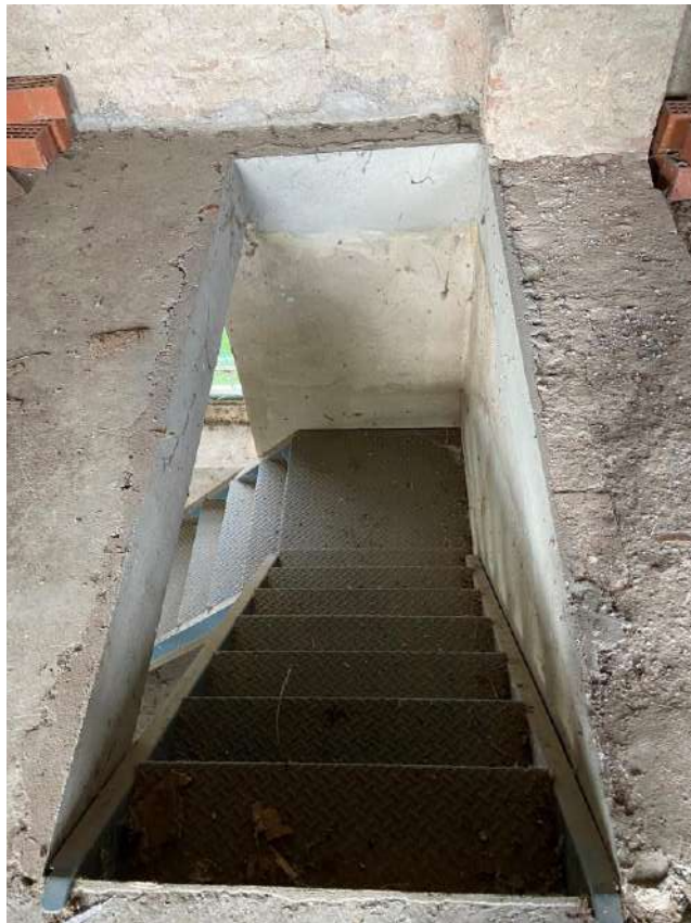
FOTO 11 : VISTA D'INSIEME SCALA DI ACCESSO DI COLLEGAMENTO SUB. 4 E SUB. 2
