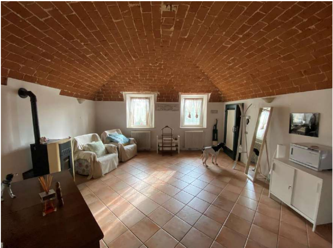
FOTO 17 : VISTA D'INSIEME INTERNA PIANO TERRENO – TAVERNETTA
