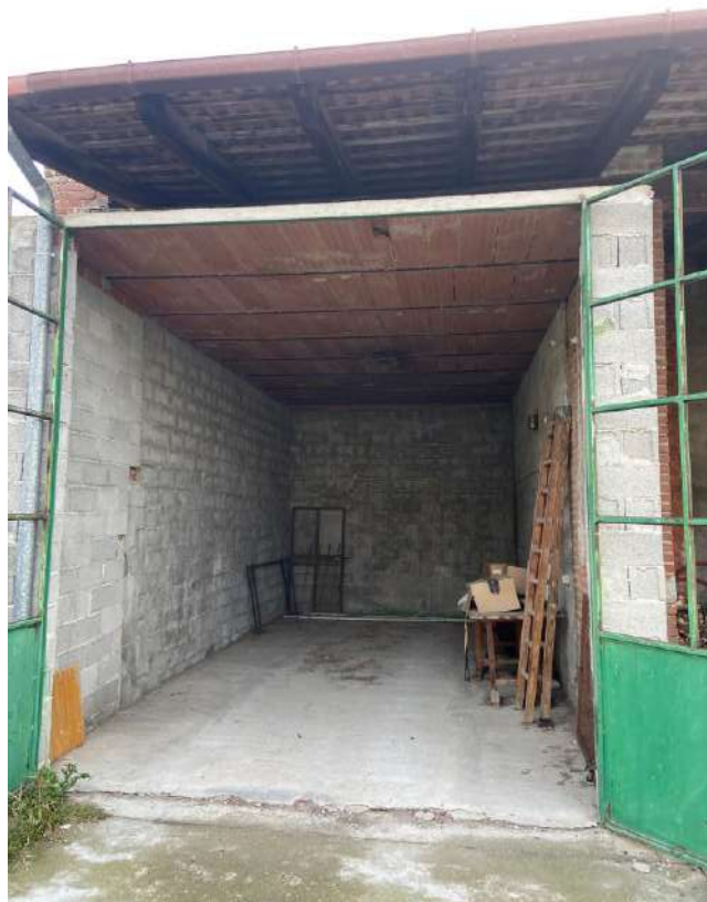
FOTO 2 : VISTA D'INSIEME INTERNA MAGAZZINO
