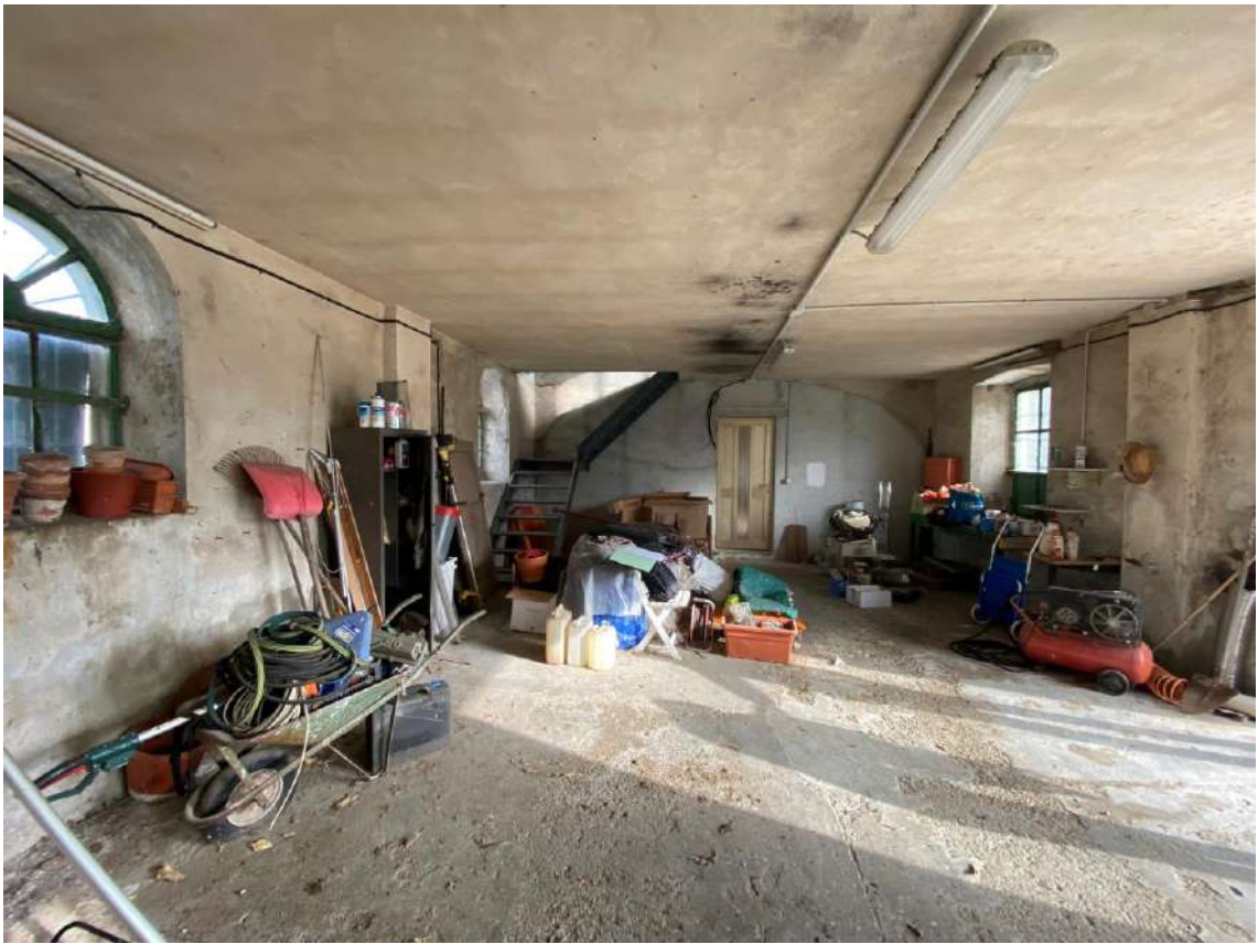
FOTO 7 : VISTA D'INSIEME INTERNA MAGAZZINO-DEPOSITO E TETTOIA
