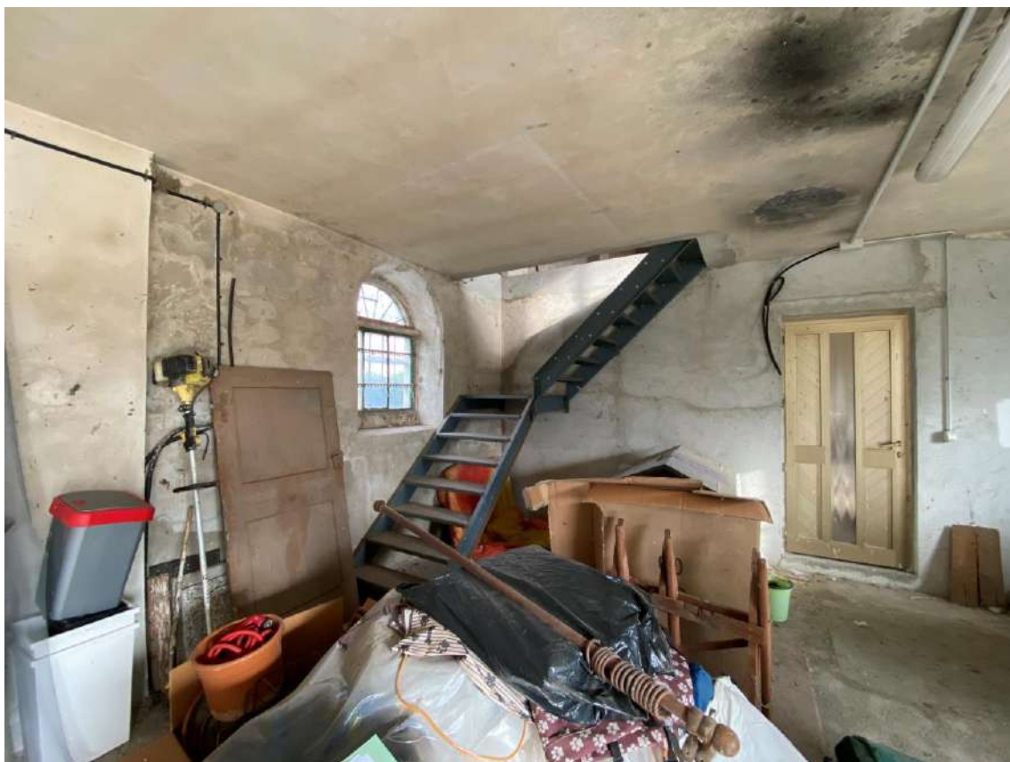
FOTO 6 : VISTA D'INSIEME INTERNA MAGAZZINO-DEPOSITO E TETTOIA
