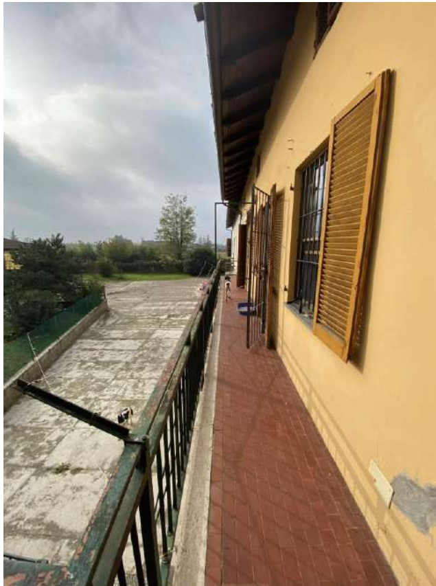
FOTO 26 : VISTA D'INSIEME ESTERNA PIANO PRIMO BALCONE LATO CORTILE
