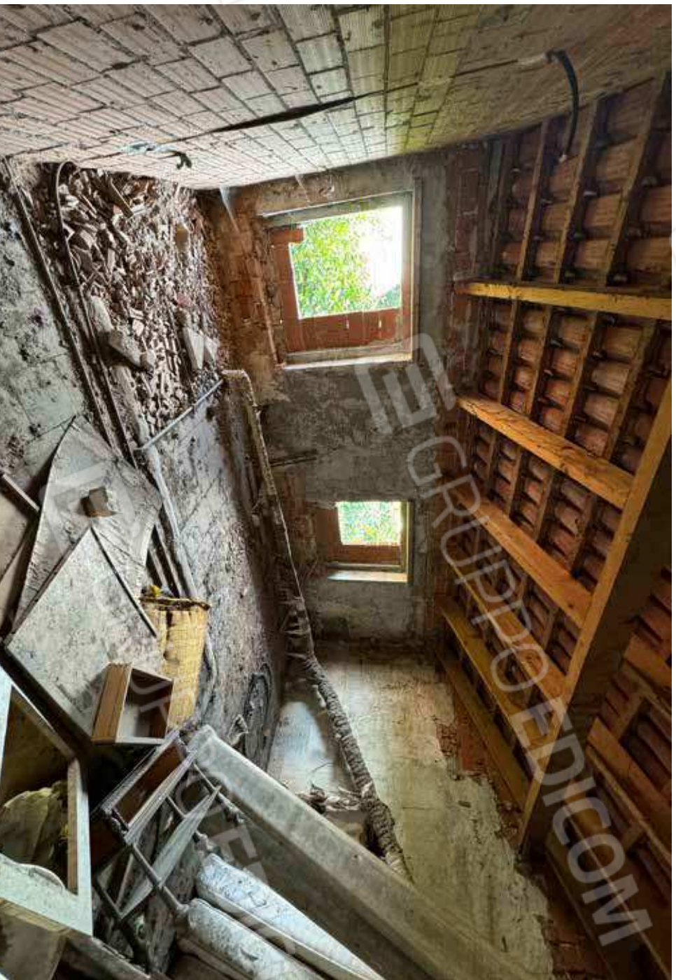
Sopra e sotto ambienti al piano sottotetto, copertura lignea ricostruita e primo lavori di ripristino - Crescentino - (foto del 14.06.24)
