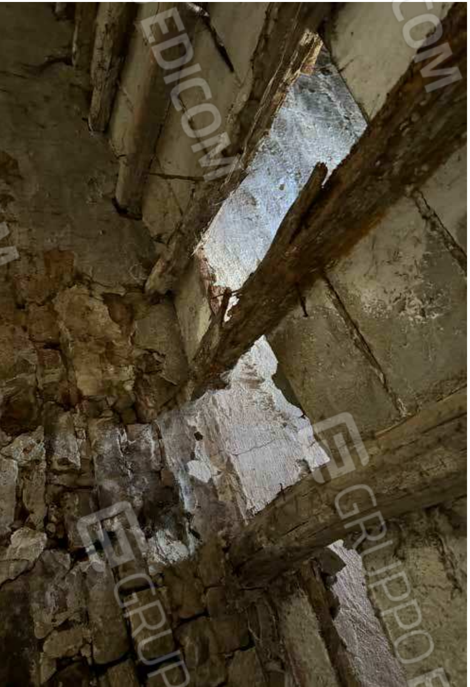
Sopra la soletta del balcone (senza ringhiera) - Sotto solaio ligneo ammalorato - Crescentino - (foto del 14.06.24)
