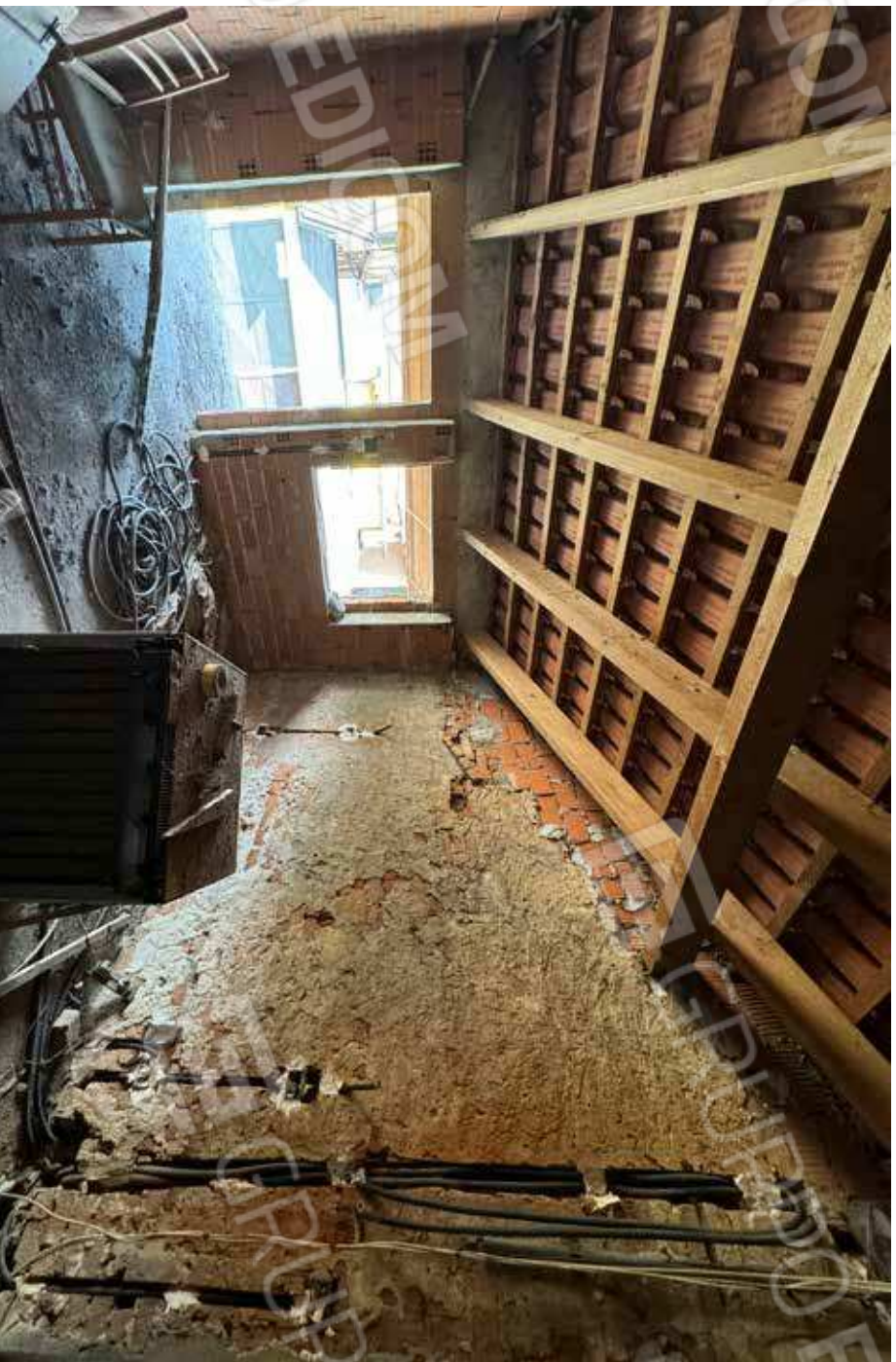
Sopra e sotto ambienti al piano sottotetto, copertura lignea ricostruita e primo lavori di ripristino - Crescentino - (foto del 14.06.24)
