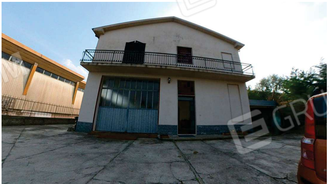
Foto 27 – Prospetto Fronte Strada
