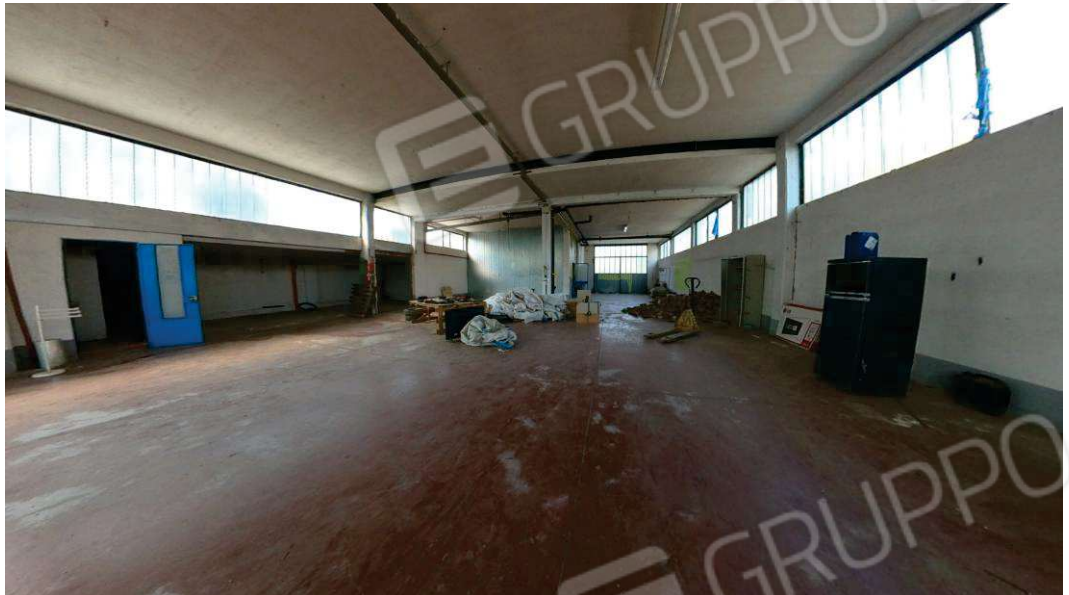
Foto 02 - Laboratorio Artigiano - Vista Interna
