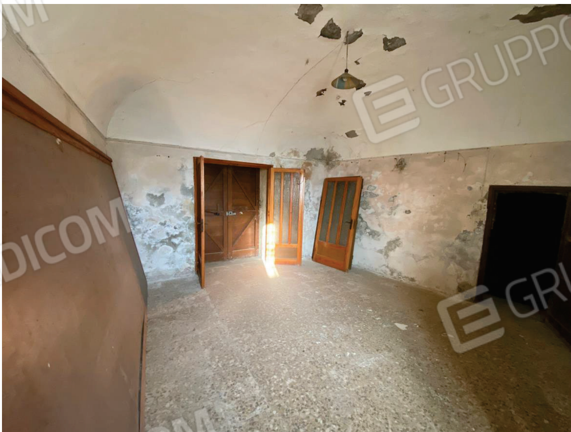
FOTO 6 : VISTA INTERNA INGRESSO PIANO TERRENO
