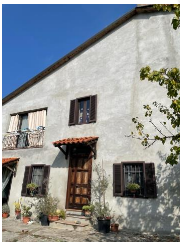
Immagine 8: Foto fabbricato civile, ingresso.
