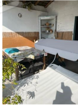
Immagine 12: Foto fabbricato civile, porticato Nord.
