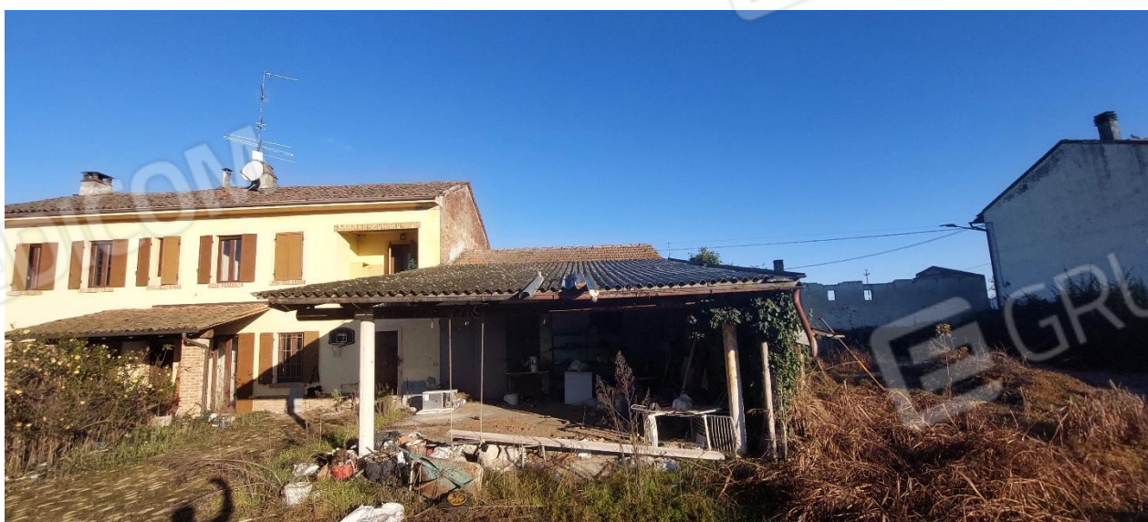
FOTO 5 – Porticato aperto lato sud
