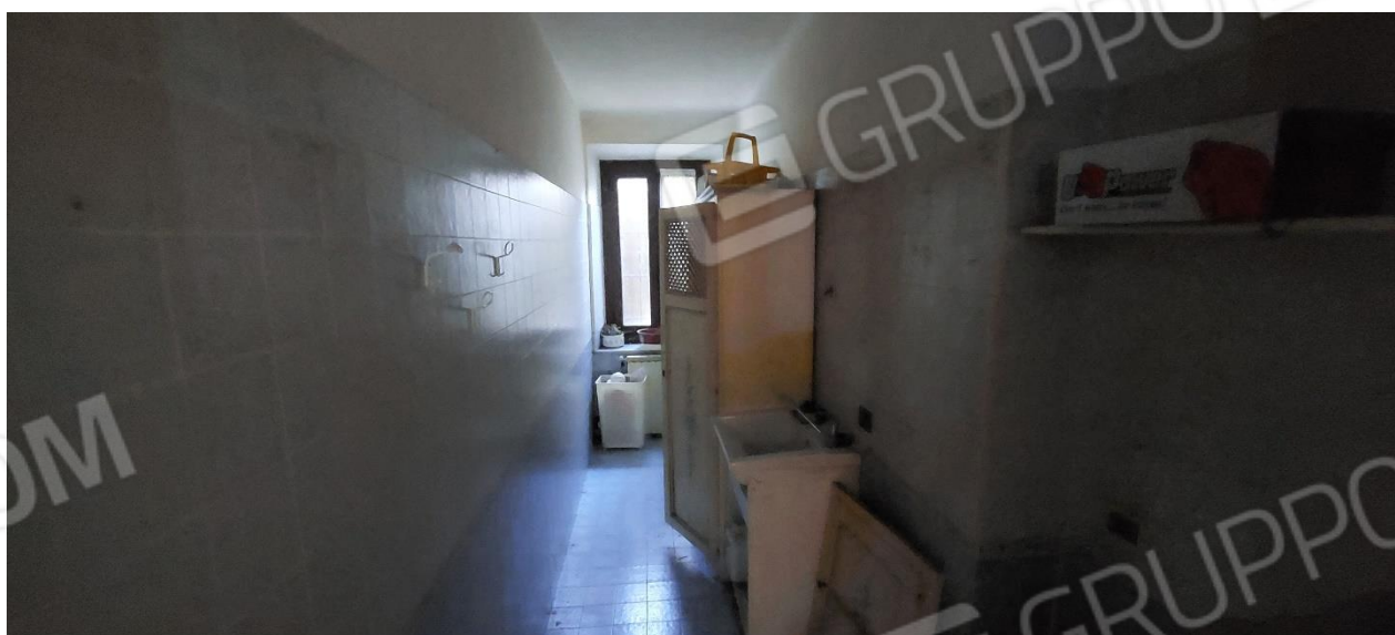
FOTO 13 – Bagno piano terreno
