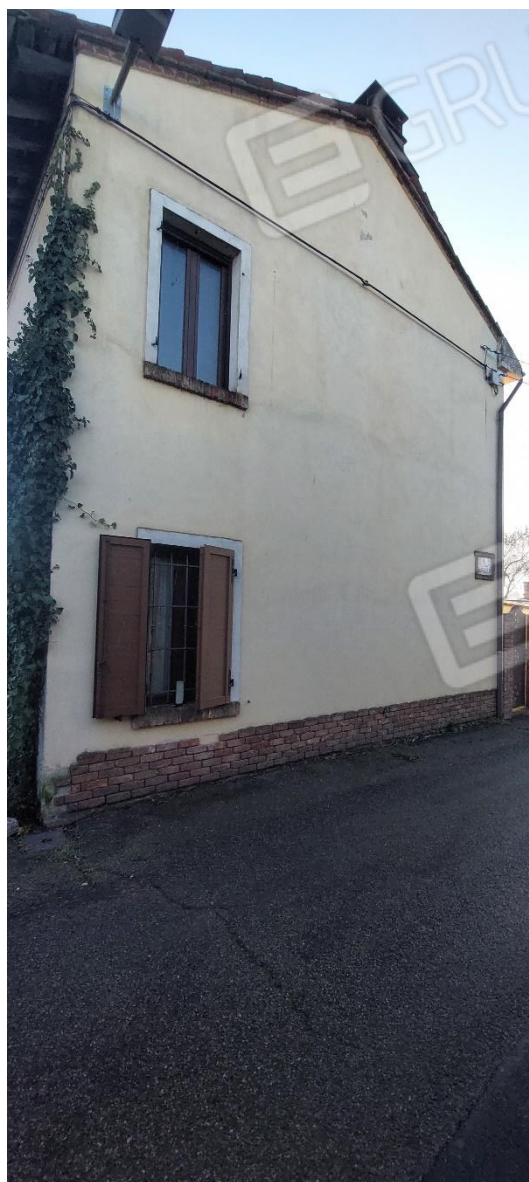
FOTO 2 – Facciata su Via Dante Alighieri n.58
