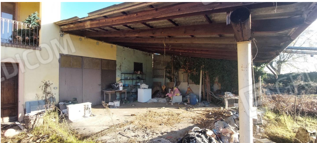
FOTO 31 – Porticato aperto con ingresso al magazzino
