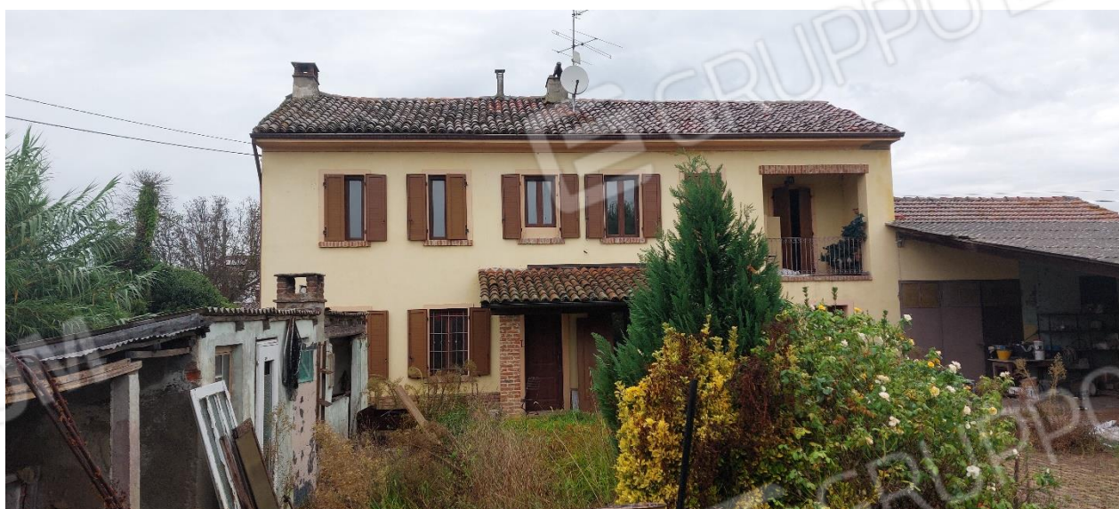
FOTO 4 – Prospetto lato sud nel cortile di proprietà
