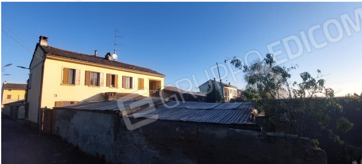
FOTO 1 – Facciata su Via Dante Alighieri n.58
