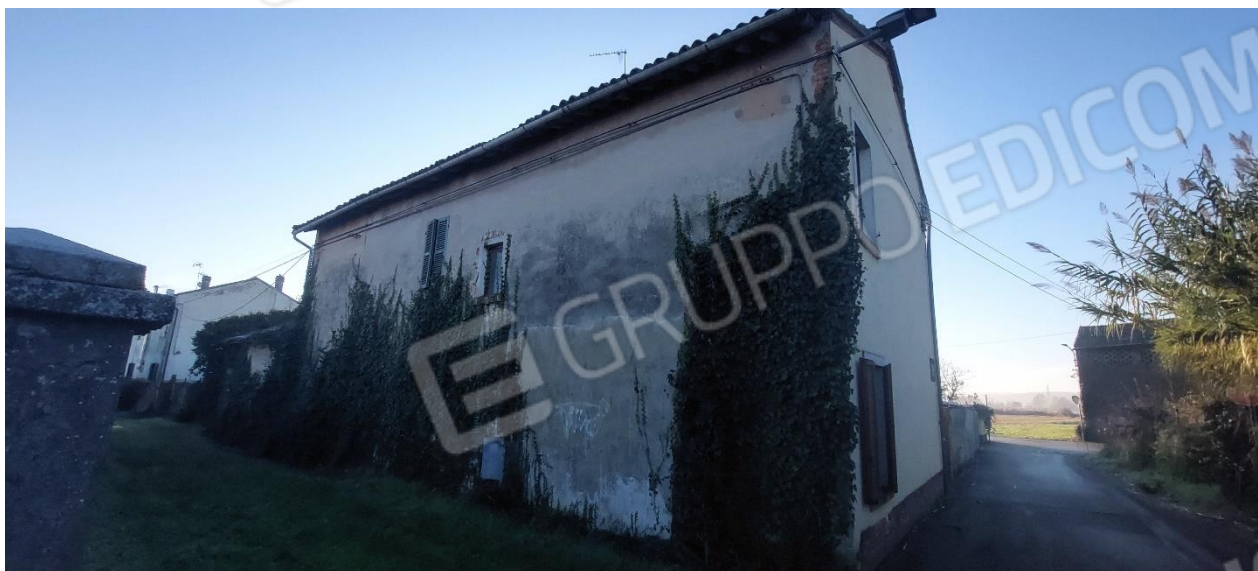
FOTO 3 – Prospetto lato nord
