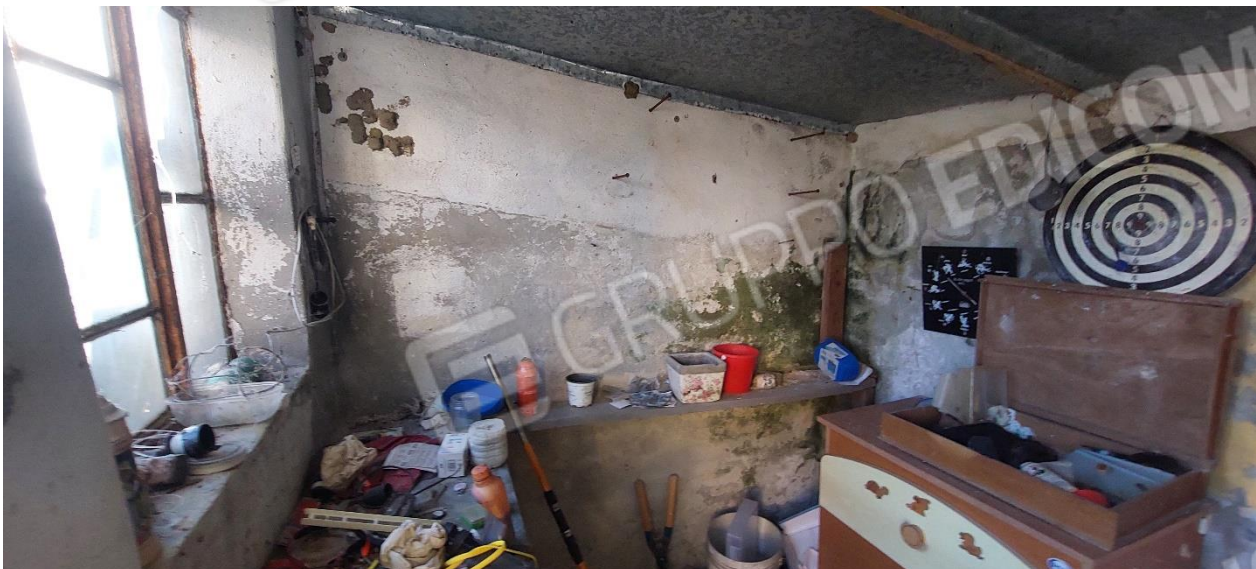
FOTO 38 – Ripostiglio basso fabbricato accessorio
