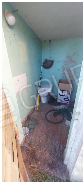
FOTO 35 – W.c. basso fabbricato accessorio
