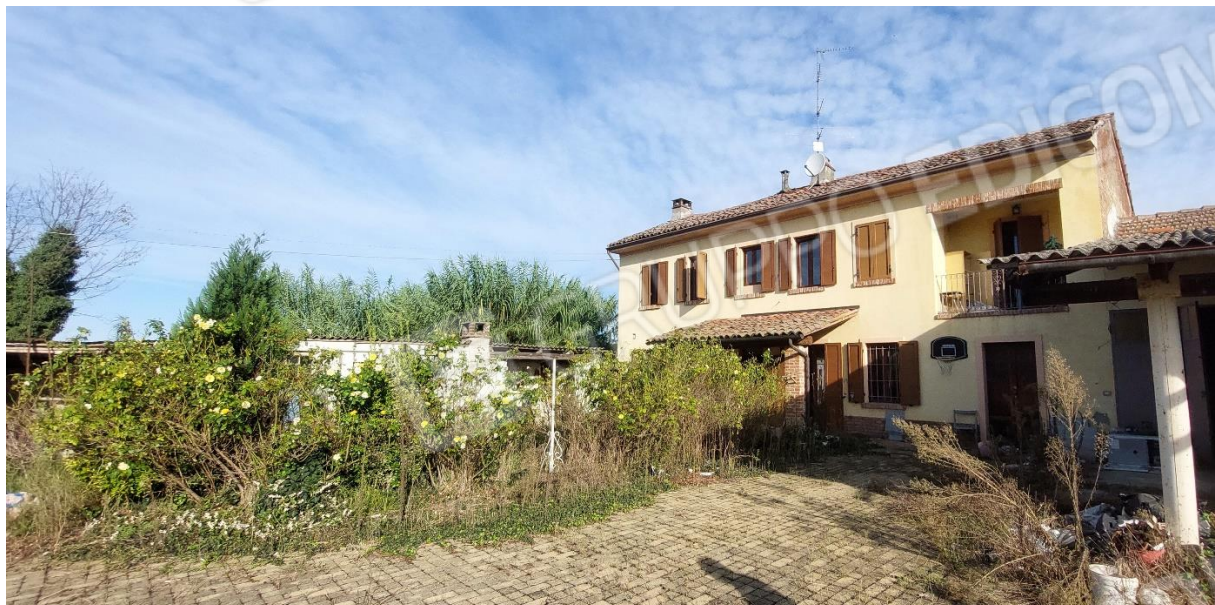
FOTO 6 – Bassi fabbricati accessori
