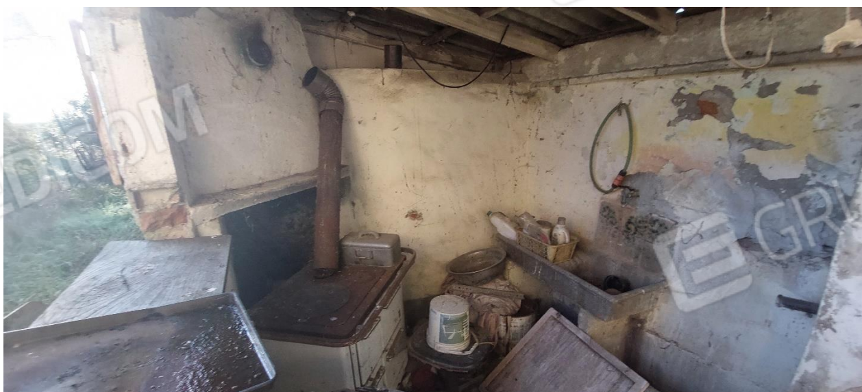
FOTO 37- Ripostiglio basso fabbricato accessorio
