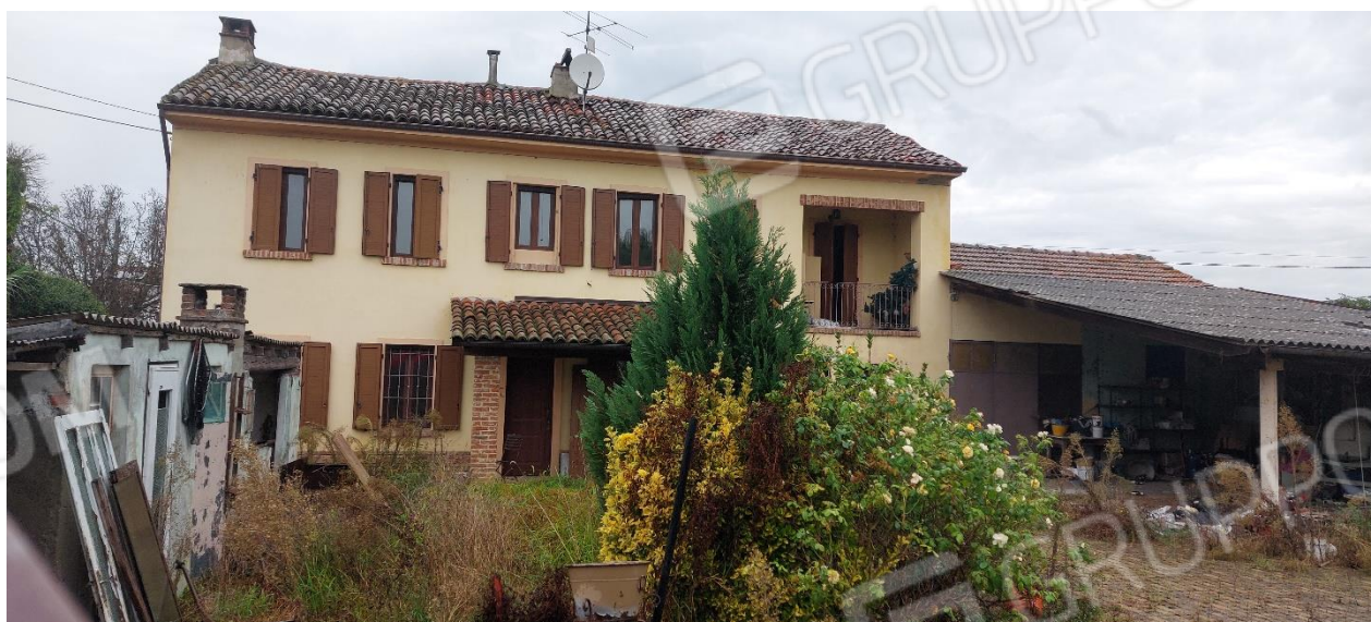
FOTO 7 – Bassi fabbricati accessori
