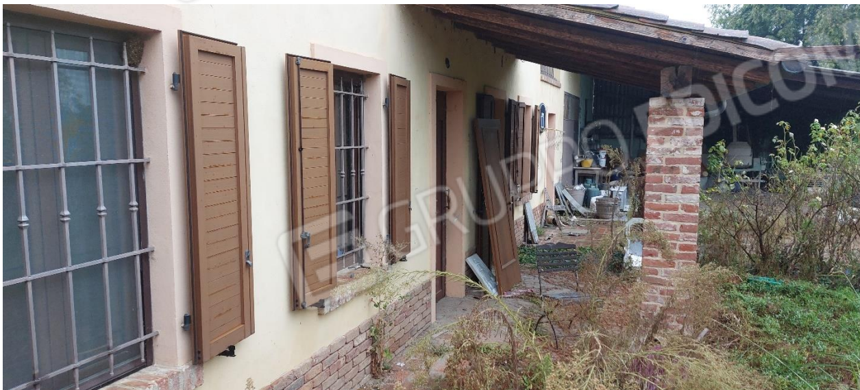
FOTO 9 – Porticato ingresso abitazione
