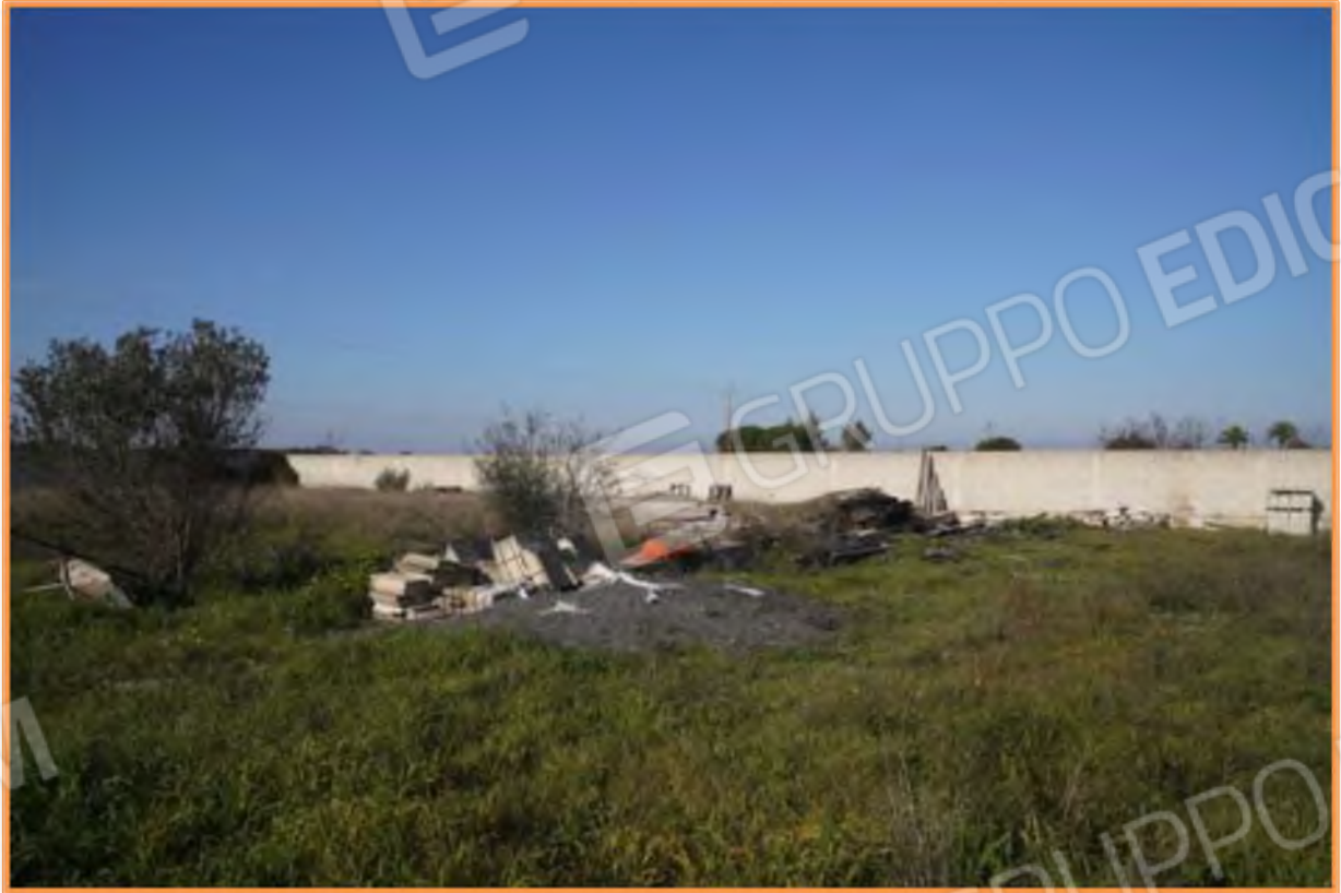
FOTO n° 8. [REDACTED] Vista della muratura di recinzione nord del terreno.
