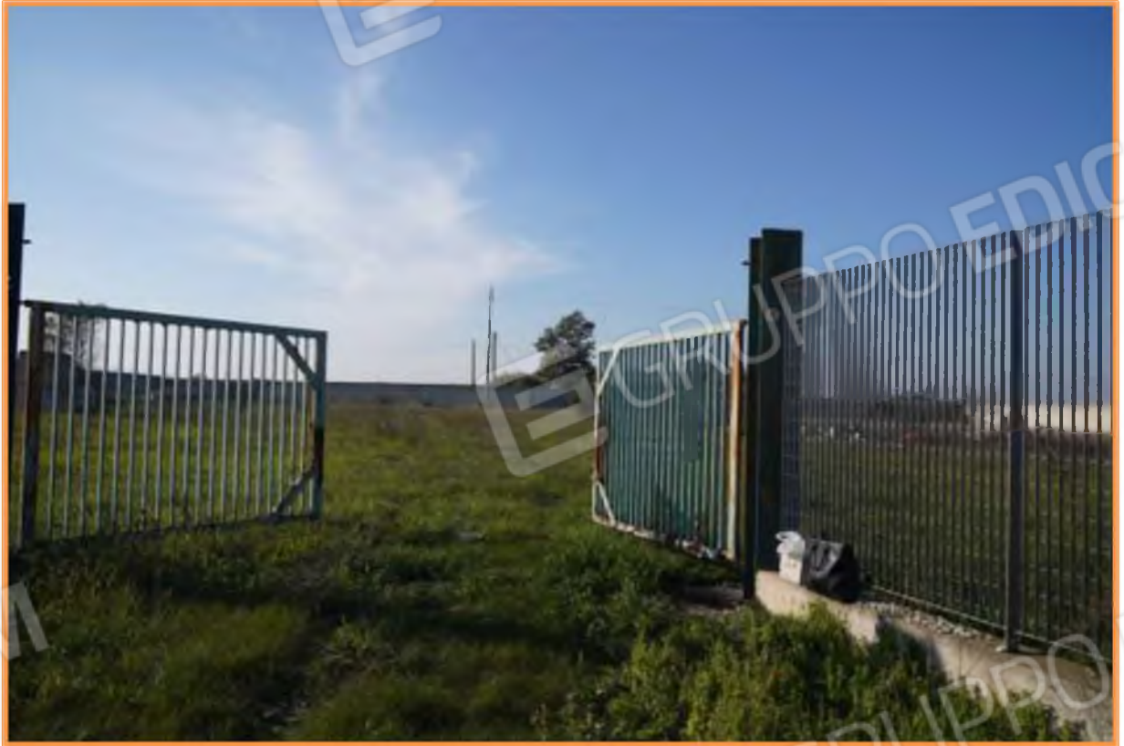
FOTO n° 3. [REDACTED] Varco di ingresso al terreno dalla strada provinciale. Vista verso la direzione ovest.
