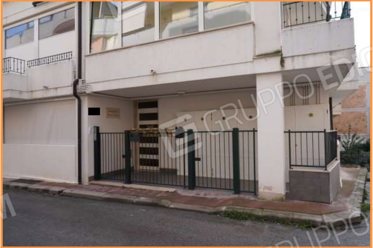
FOTO n° 4. Particolare del porticato di ingresso all'edificio e del portone [REDACTED]
