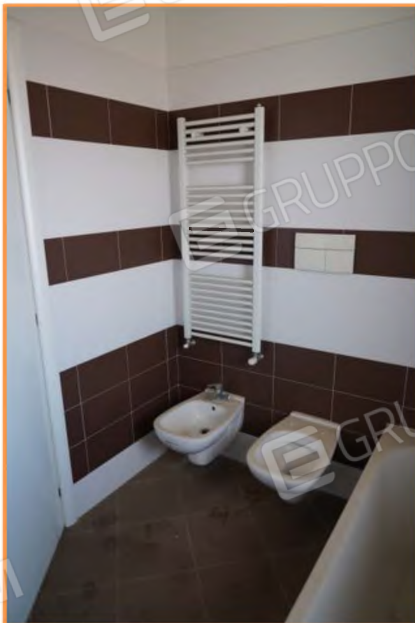
FOTO n° 12. Vano bagno, vista verso la direzione sud-ovest.
