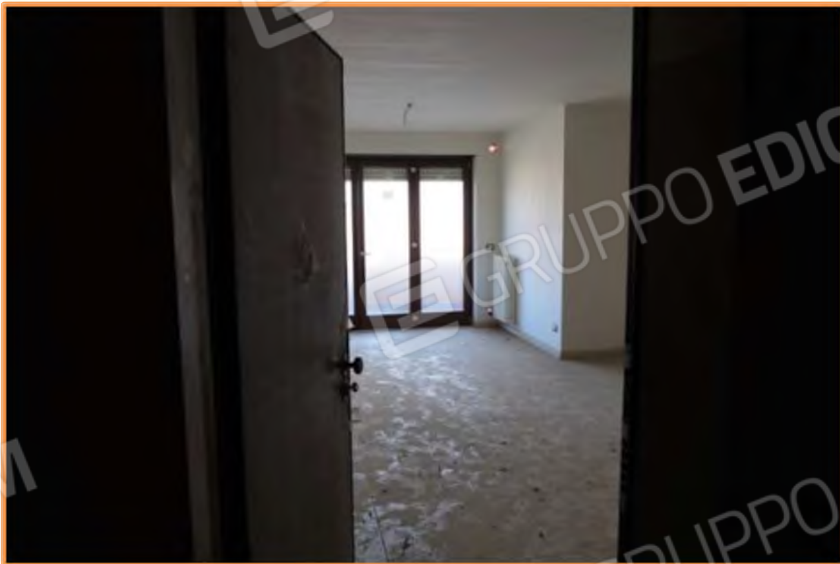
FOTO n° 6. Piano secondo Portoncino di ingresso all'unità staggita. Vista verso a direzione nord.
