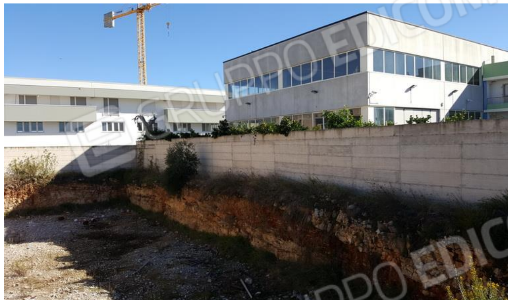
FOTO 2.8: Pareti di scavo sul confine Est
