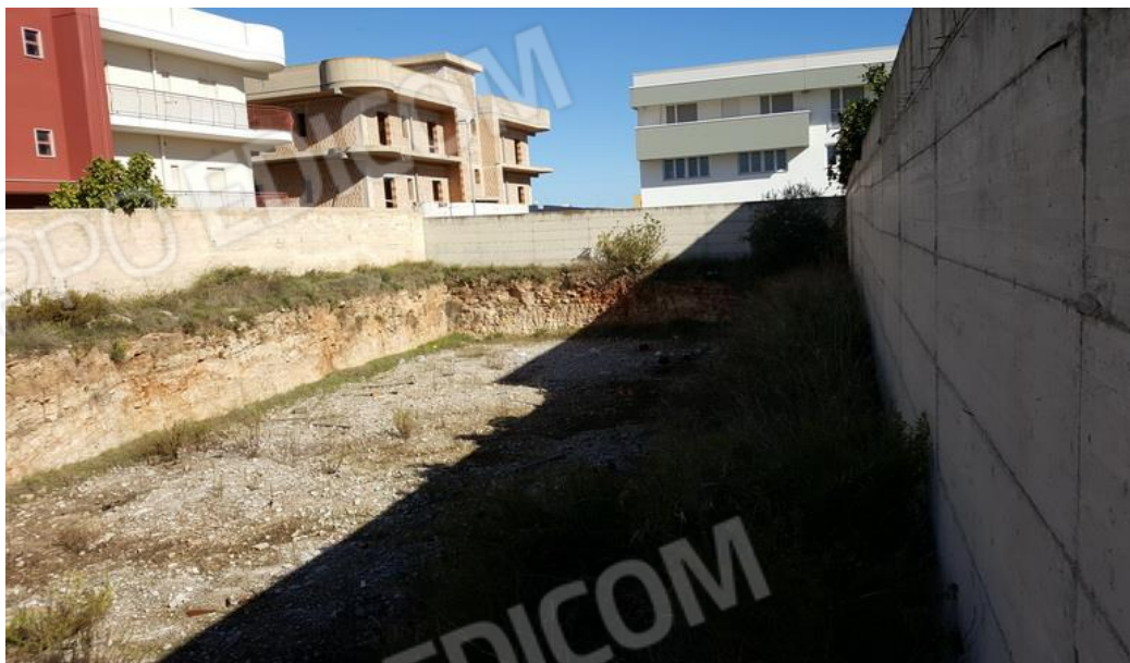
FOTO 2.7: Pareti di scavo sul confine Nord ed Ovest
