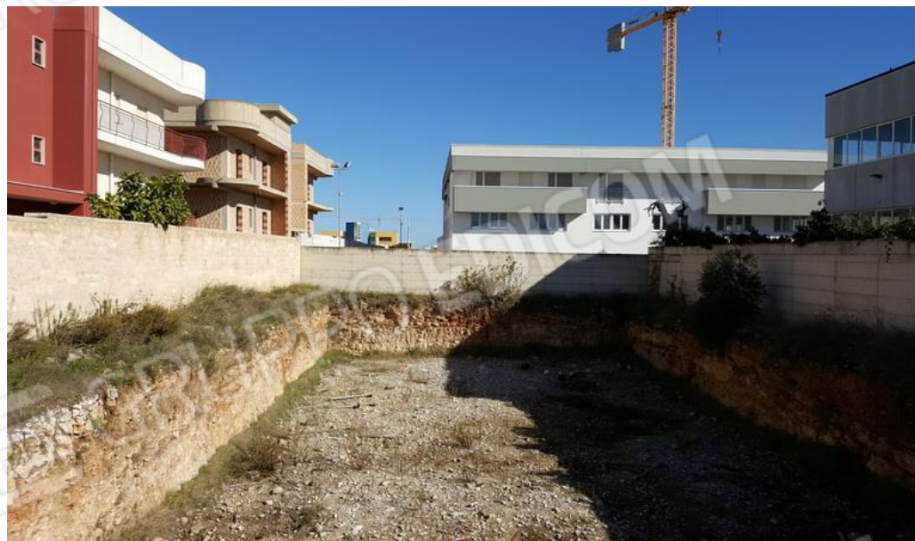
FOTO 2.6: Lotto 2 in stima (presenza di uno scavo a cielo aperto)
