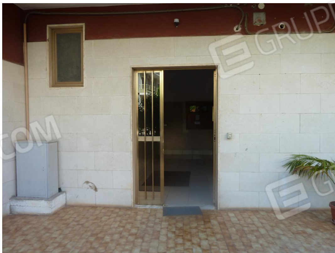
Foto 2 – Portone di accesso alla palazzina “Blocco 3”
