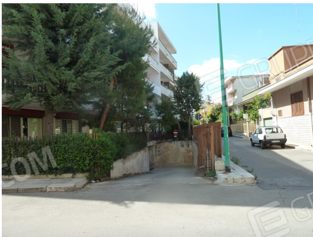
Foto 22 – Rampa di Via Vittorio Veneto
