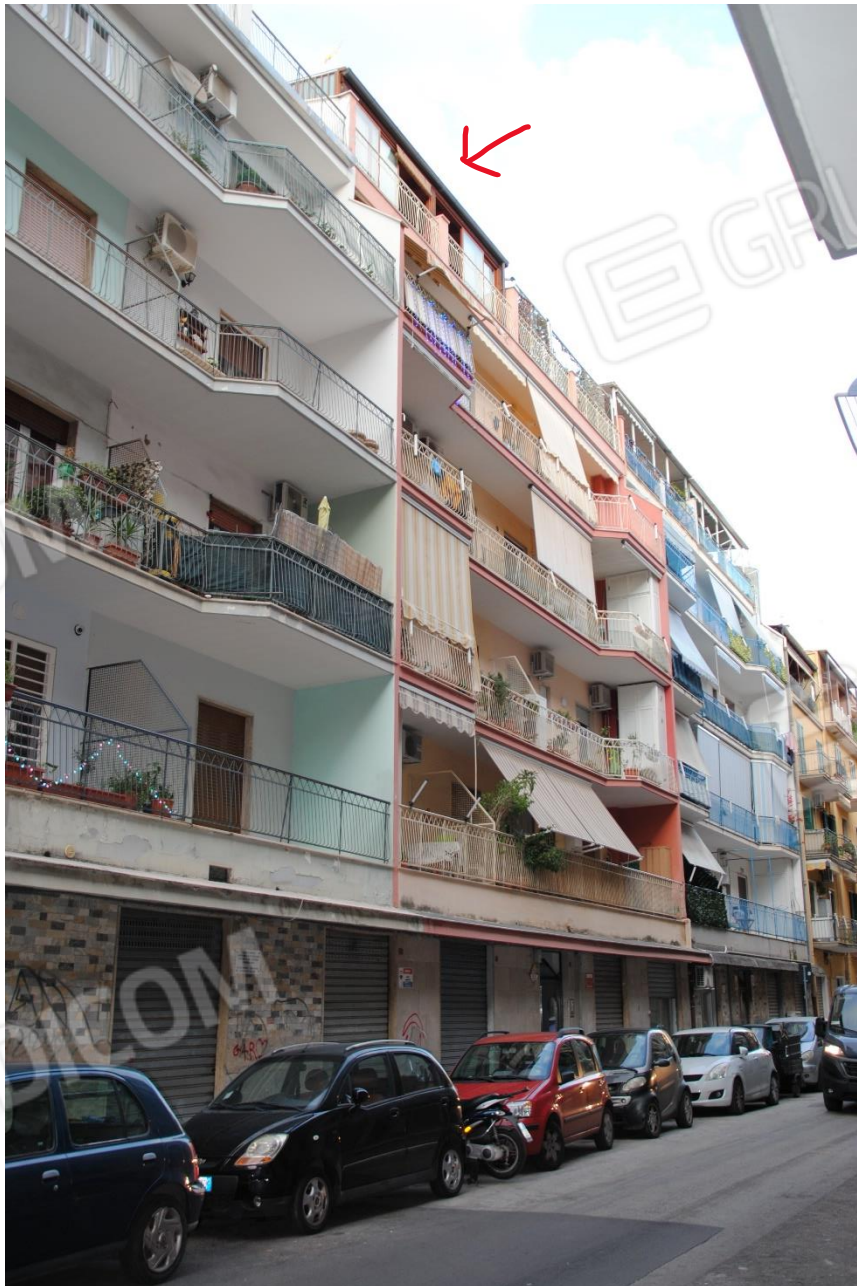
Foto 1: Ripresa del prospetto a sud su Via Monte Nevoso.
