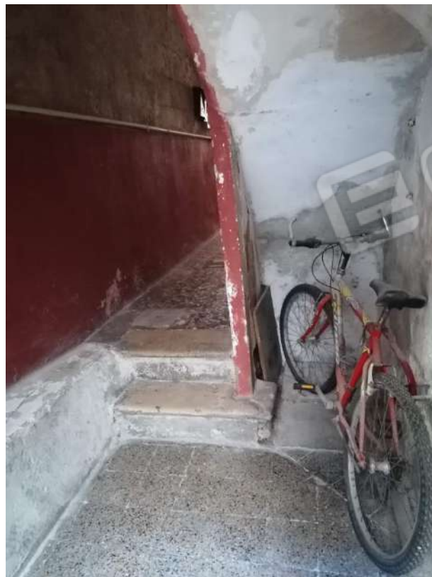
FOTO 3 - Accesso al deposito
