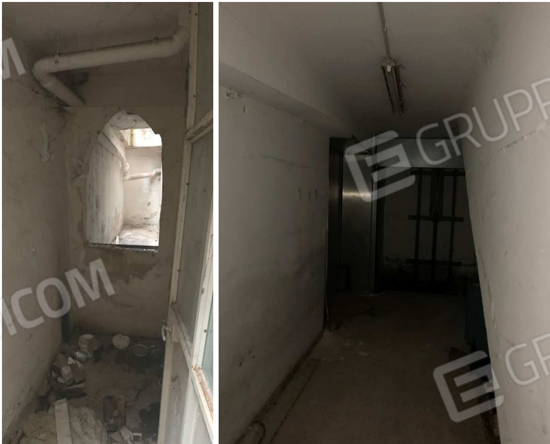
Foto nn. 18-19. Piano Interrato. Intercapedine (vano deposito) e disimpegno
