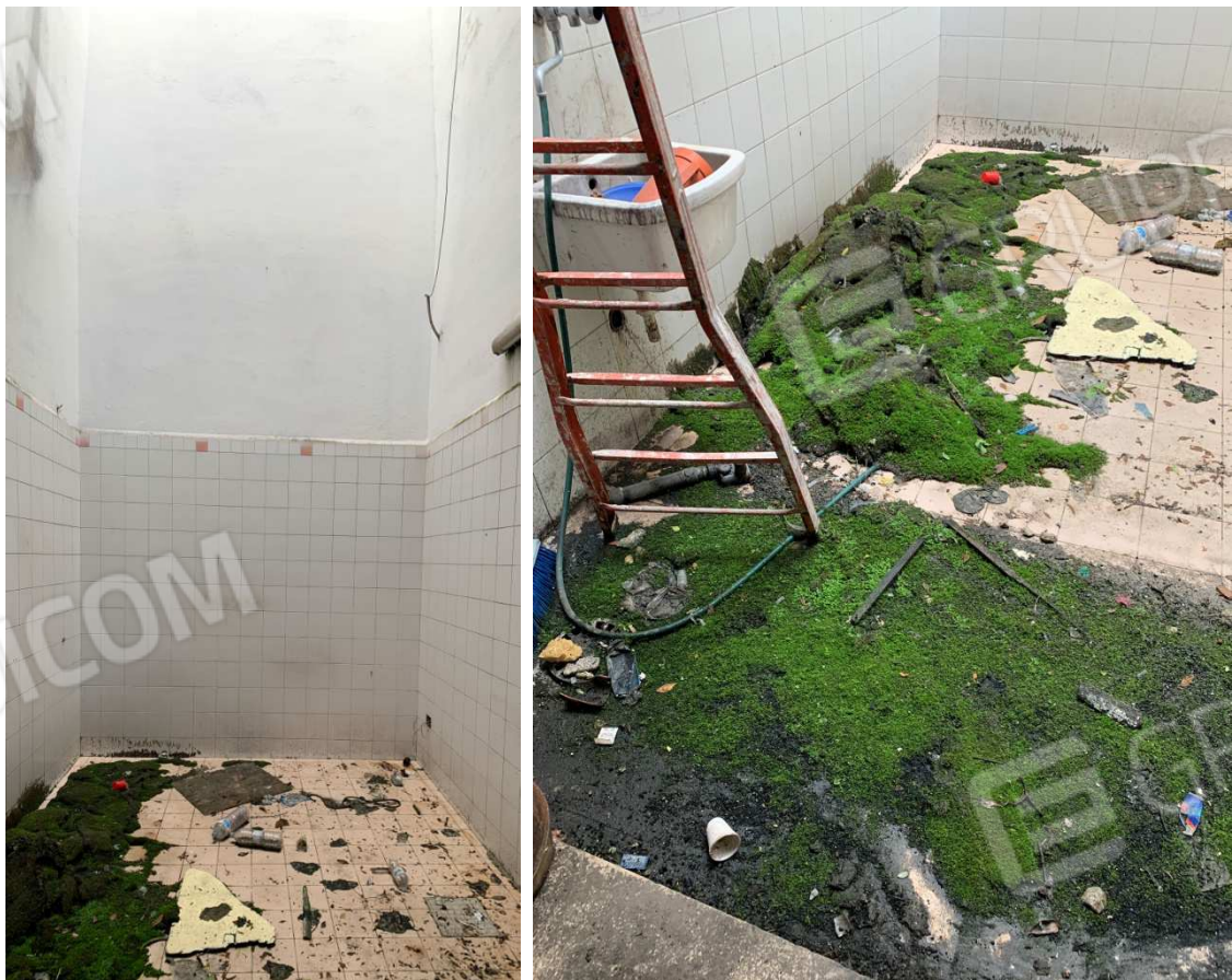
Foto nn. 8-9. Piano Terra. Chiostroina
