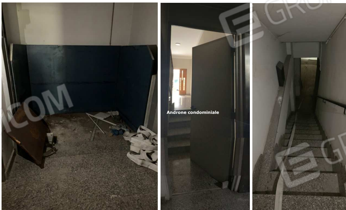
Foto nn. 13-14-15. Piano Terra. Montacarichi, collegamento all'androne condominiale e scala di collegamento al piano interrato
