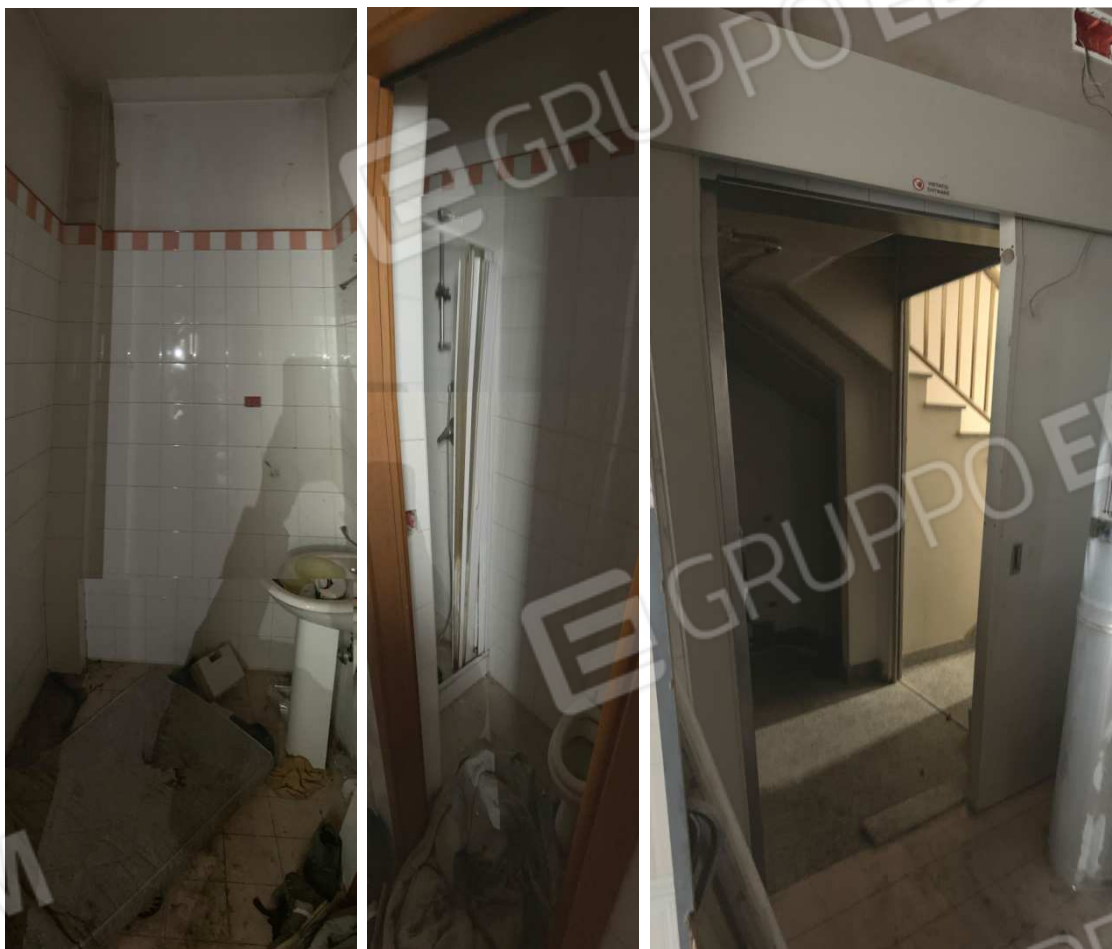
Foto nn. 10-11-12. Piano Terra. Bagno e vano disimpegno
