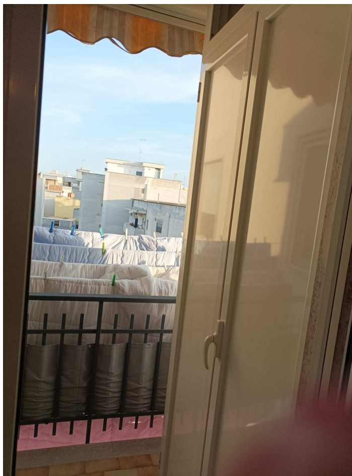
Foto n°11: Balcone lato cucina con ripostiglio da rimuovere
