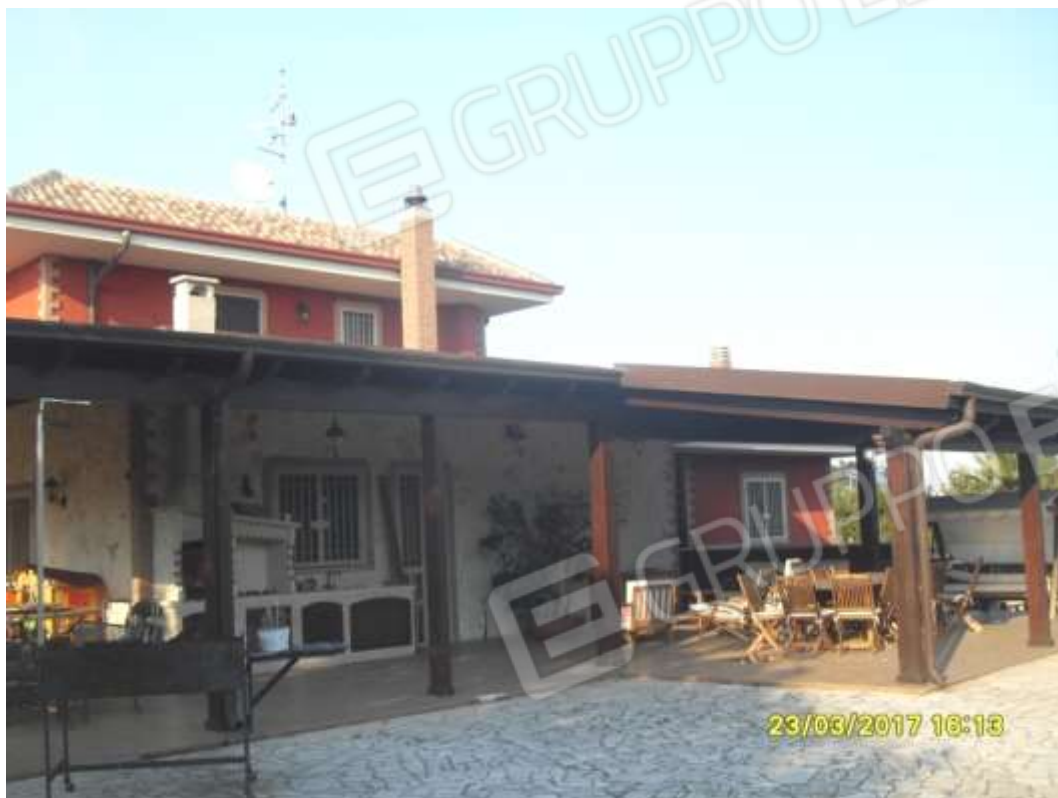
N. 9 VISTA TETTOIA
