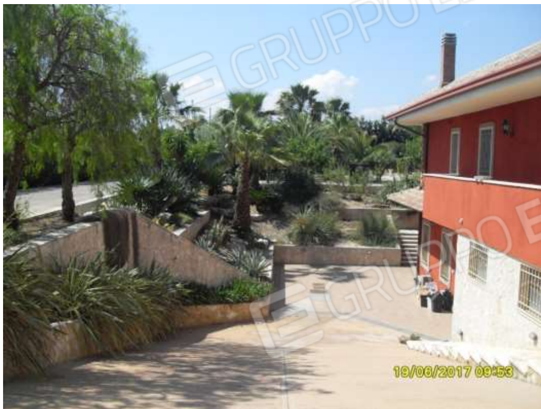
N. 5 VISTA RAMPA E FACCIATA EST
