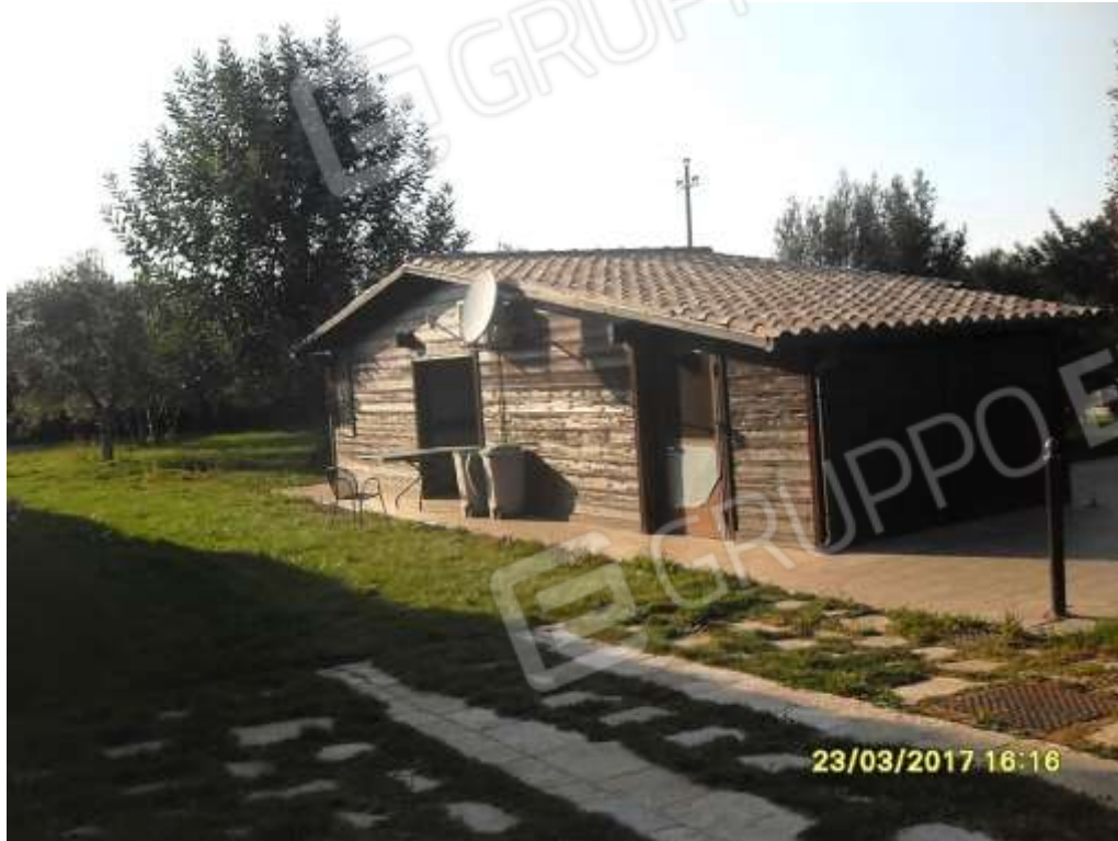
N. 66 VISTA ESTERNA
