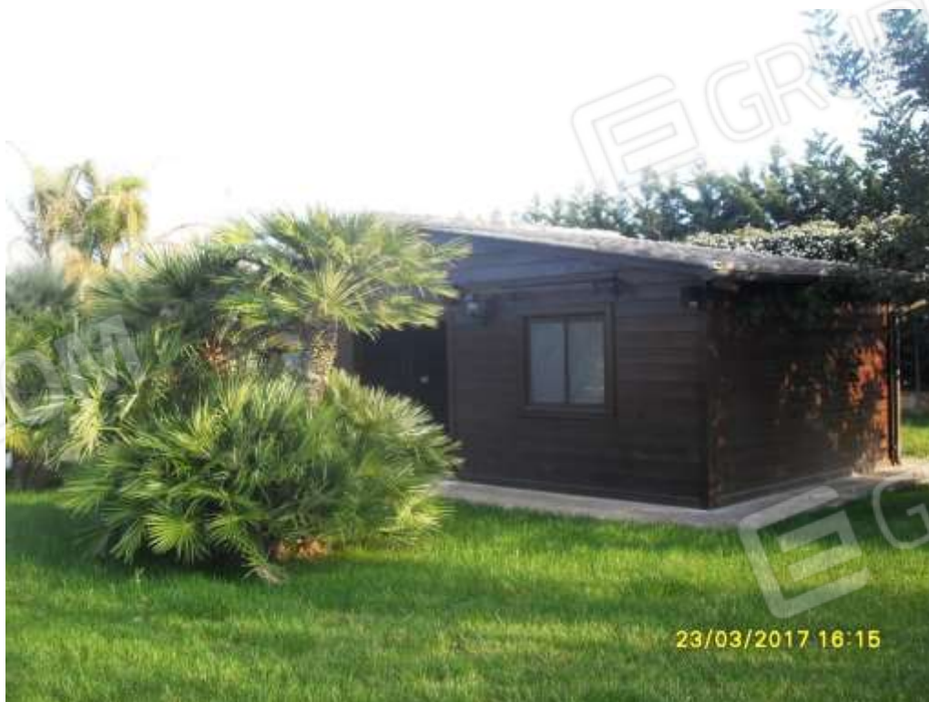
N. 67 VISTA ESTERNA
