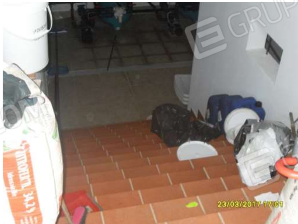
N. 69 VANO SCALA E VANO IMPIANTI PISCINA
