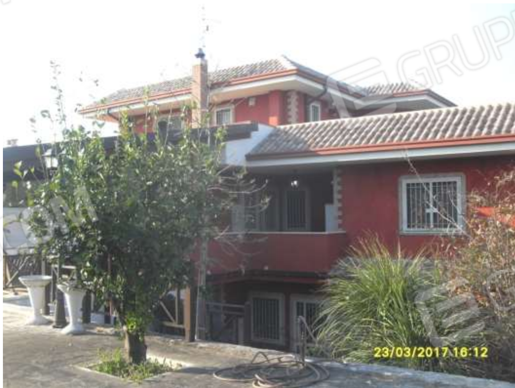
N. 8 VISTA FACCIATA SUD
