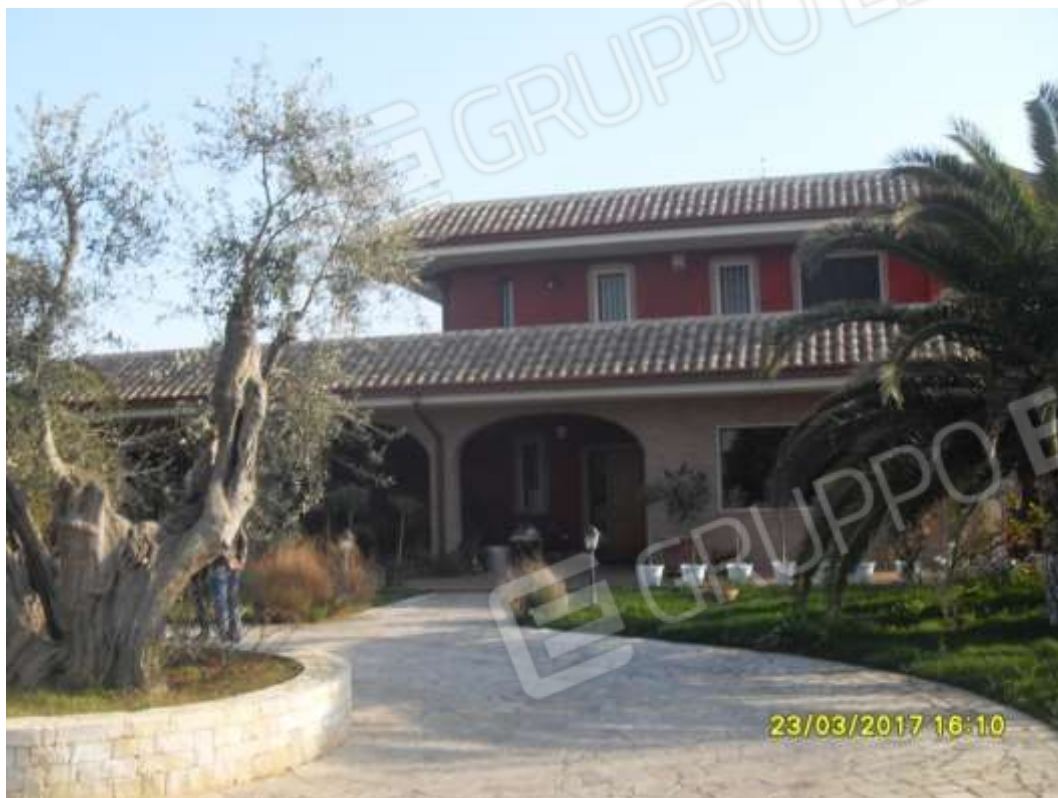
N. 3 VISTA FACCIATA NORD
