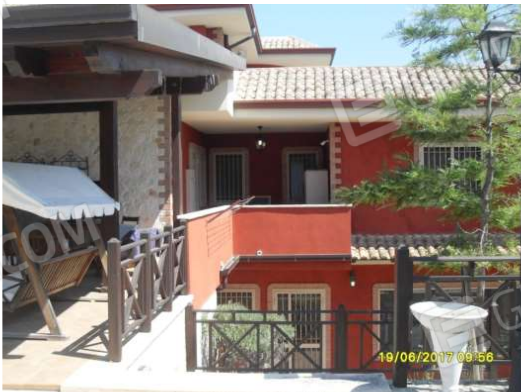
N. 10 FACCIATA SUD
