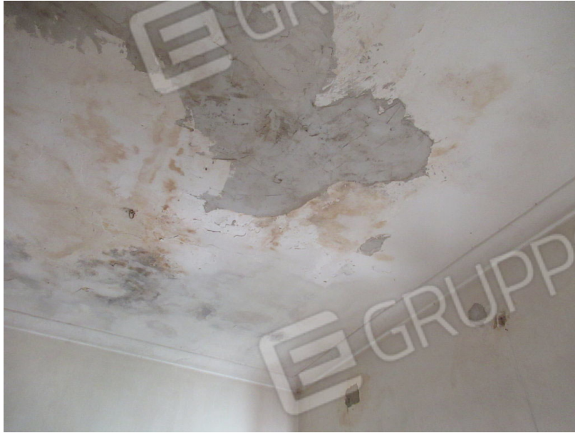
PIANO PRIMO – CAMERA - SOFFITTO
