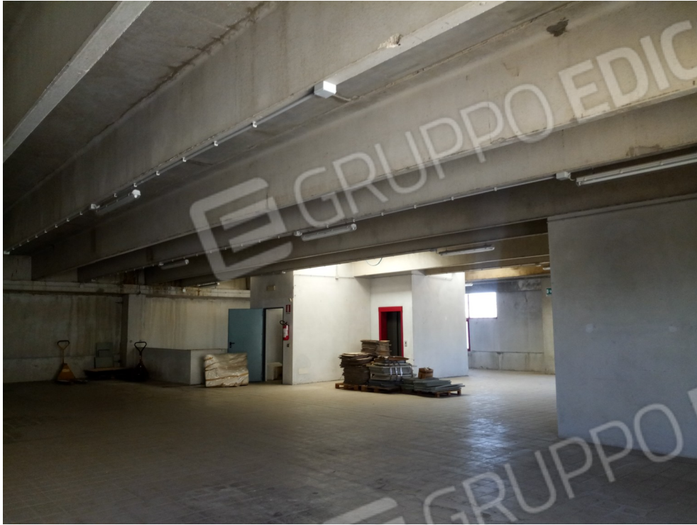
foto 5: piano primo – accessi ascensore e servizio igienico dal vano principale
