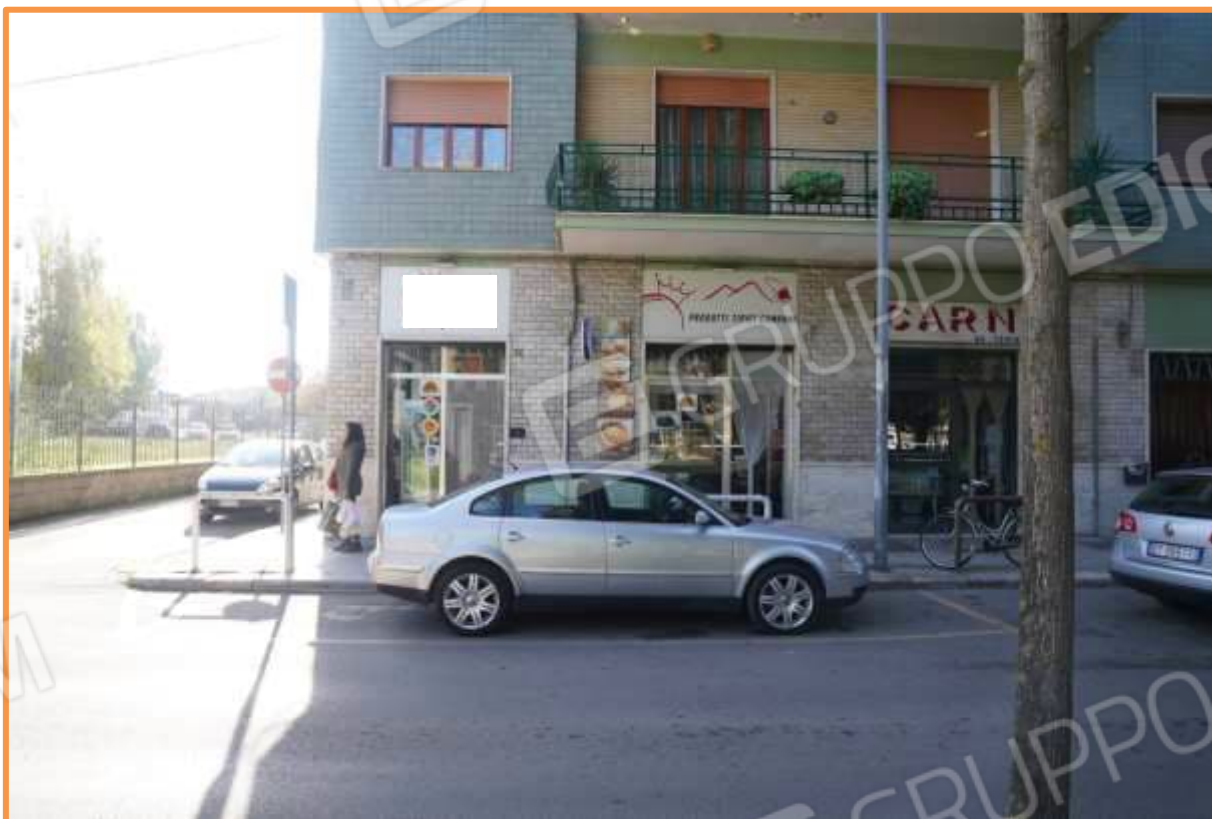
FOTO n° 2. Gioia Del Colle. Prospetto dell'unità staggita sulla via Regina Elena. Vista verso la direzione sud-ovest.
