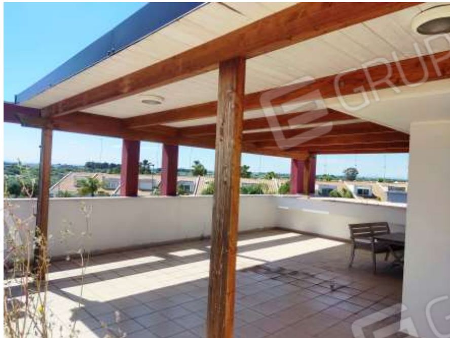
Appartamento, piano lastrico solare: tettoia (Fig. 26, p.lla 785, sub. 11)
