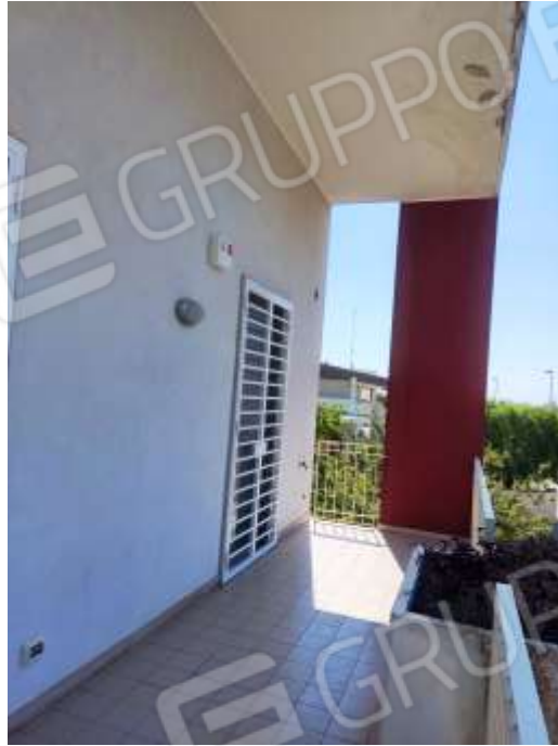
Appartamento, primo piano: balcone 1 (Fig. 26, p.lla 785, sub. 11)
