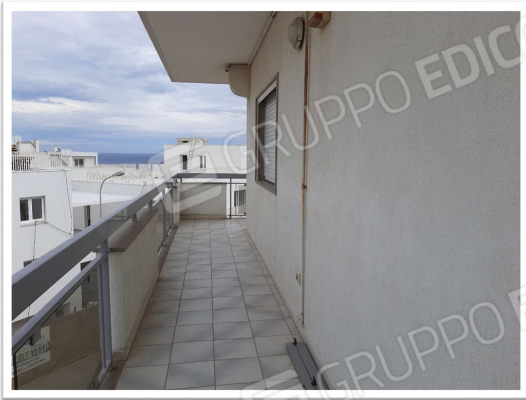
FOTO 13 – BALCONE LATO CUCINA
