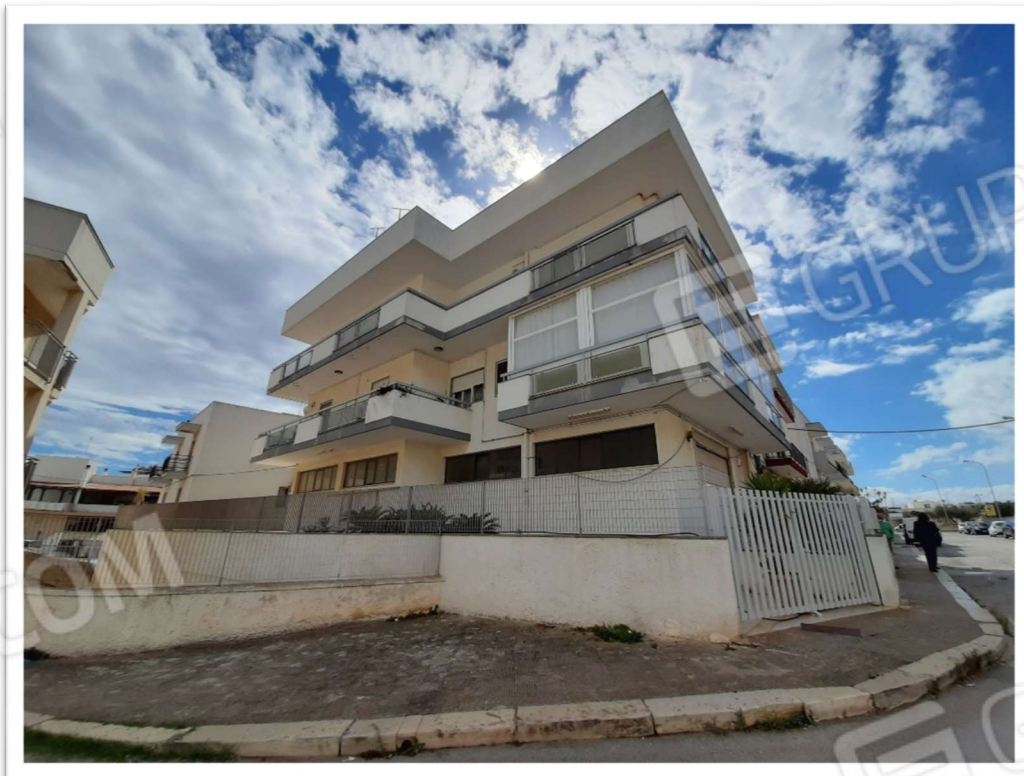
FOTO 2 – ALTRA VISTA FABBRICATO
