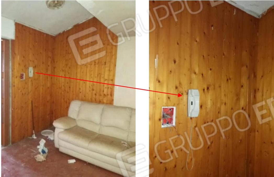
Foto n. 20-21 Predisposizione citofono e quadretto elettrico interno divelto
