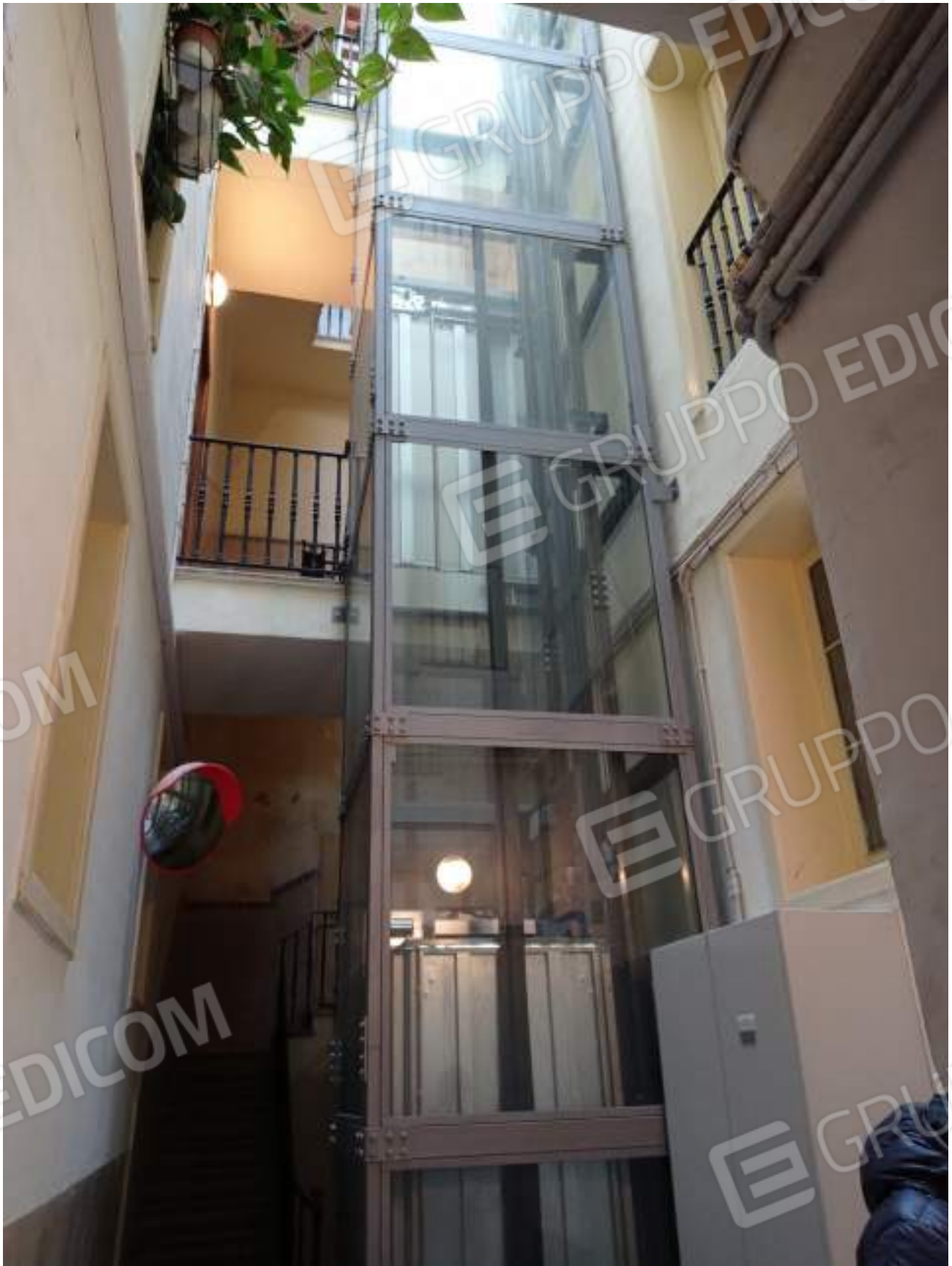
Pozzo luce vano scala
