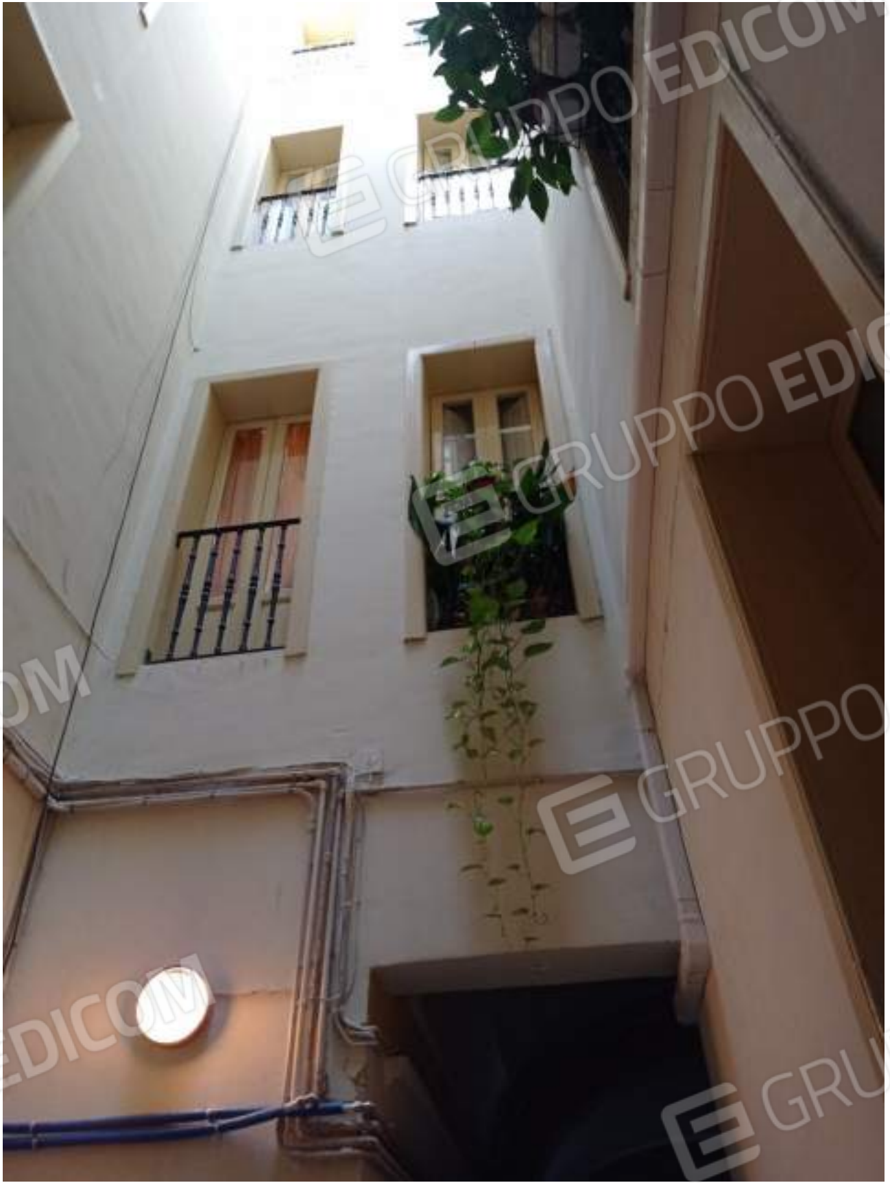
Dettaglio pozzo luce
