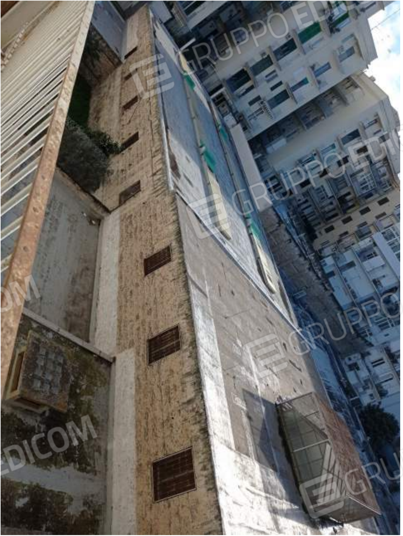
Vista su cortile interno
