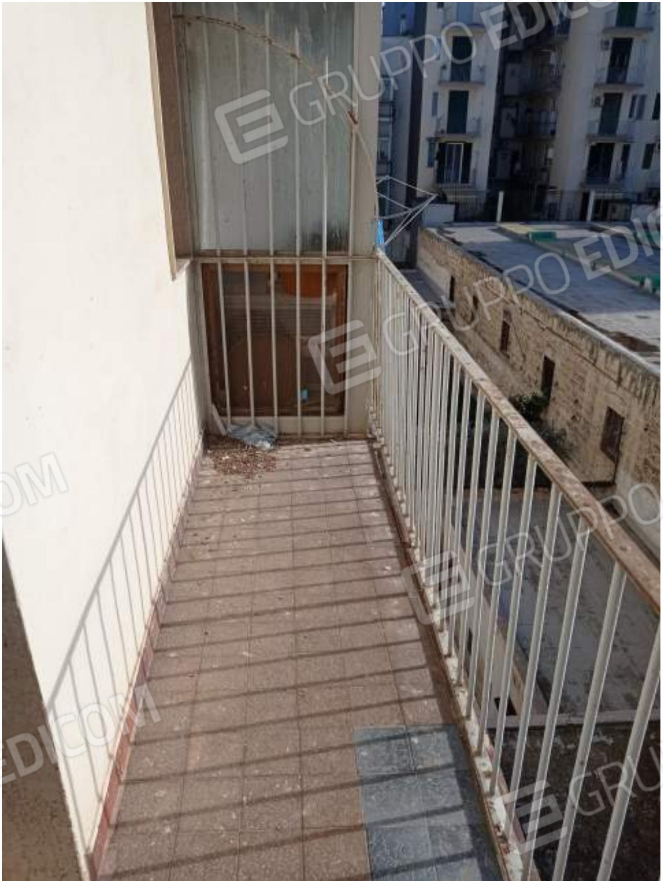
Balcone su cortile interno
