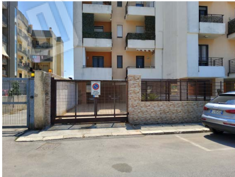
FOTO 1: Accesso carrabile su via Quasimodo
