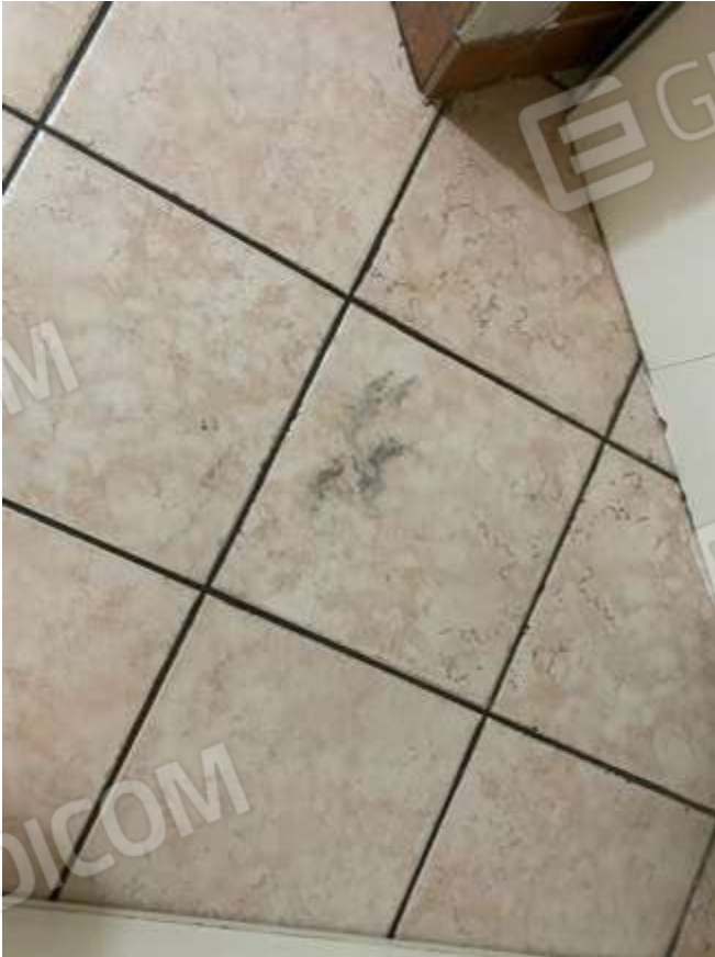
Pavimentazione piano terra
