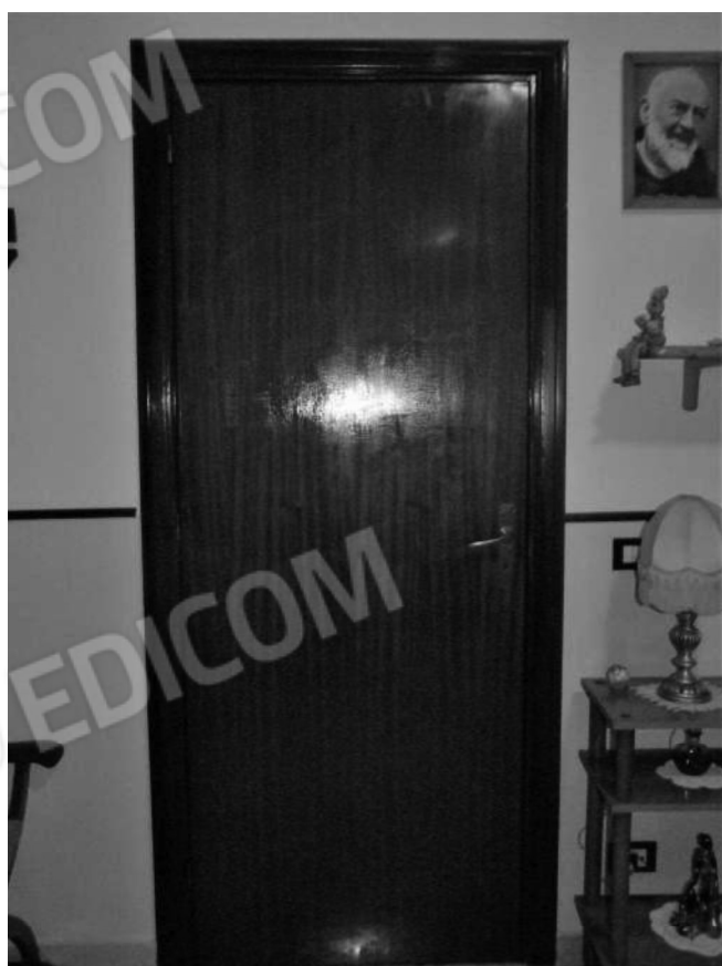
Foto 56 - Particolare infisso interno.
