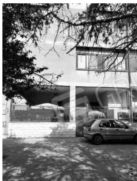
Foto 5 – Prospetto posteriore del bene.
