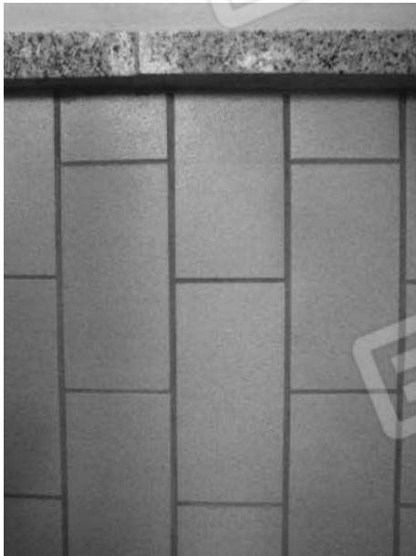
Foto 49 – Particolare rivestimento delle pareti del Patio posteriore.
