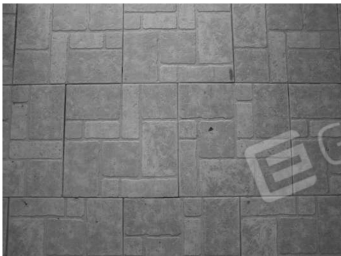
Foto 43 - Particolare pavimentazione esterna del Patio 1.
