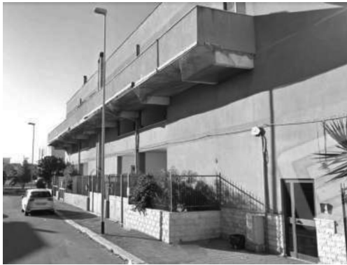
Foto 1 – Vista dell'edificio su via C. Cattaneo.
