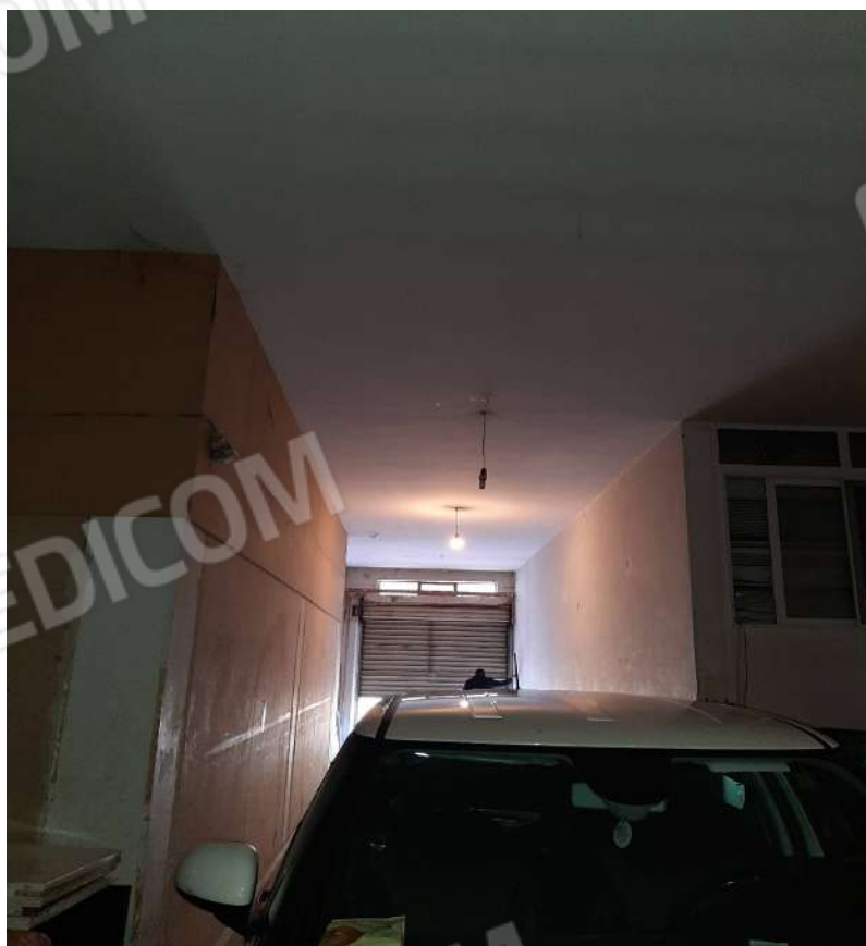
Foto n. 5 Accesso zona locale n.c. 9
