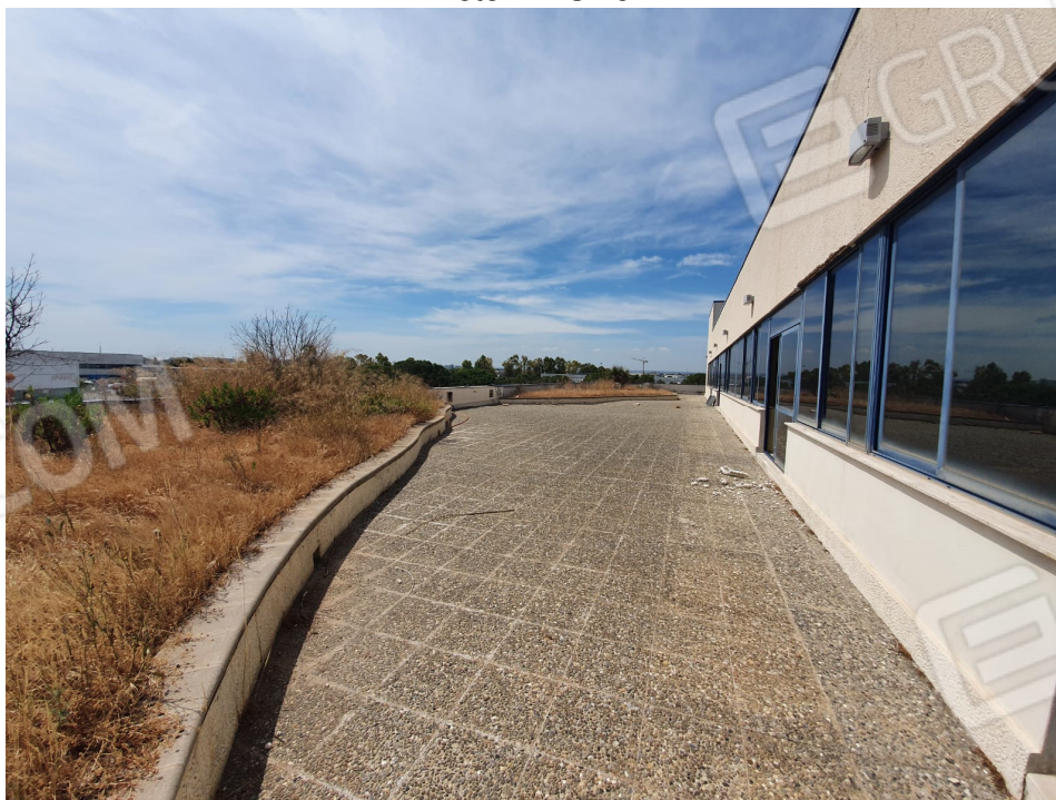
Foto 12: Terrazza cortile interno
