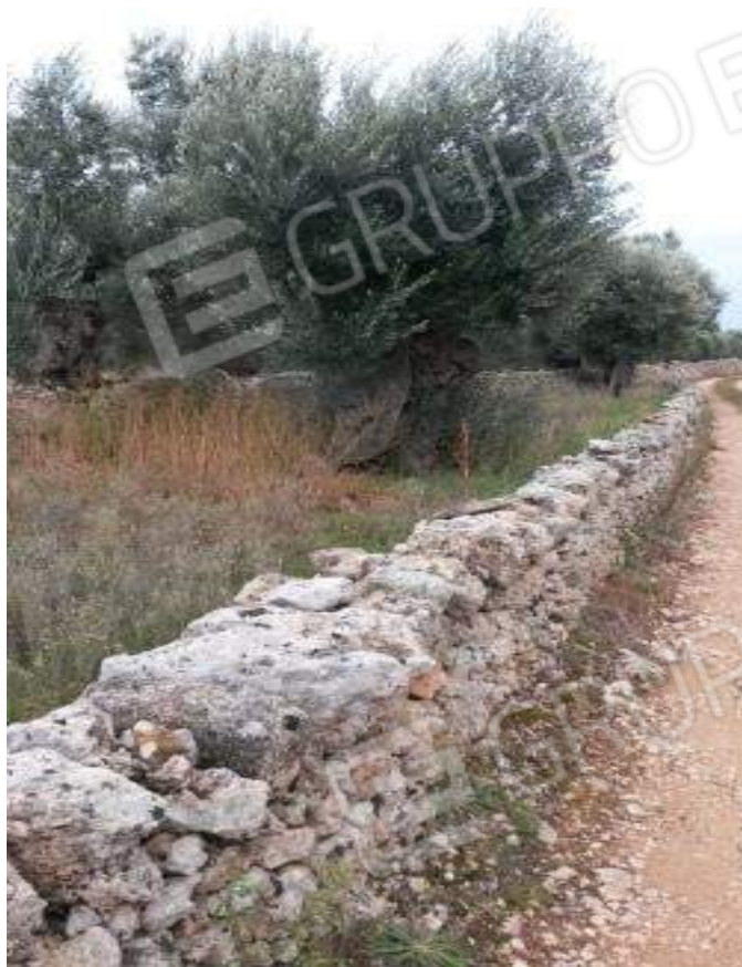
foto 11: lato sud p.lla 84
